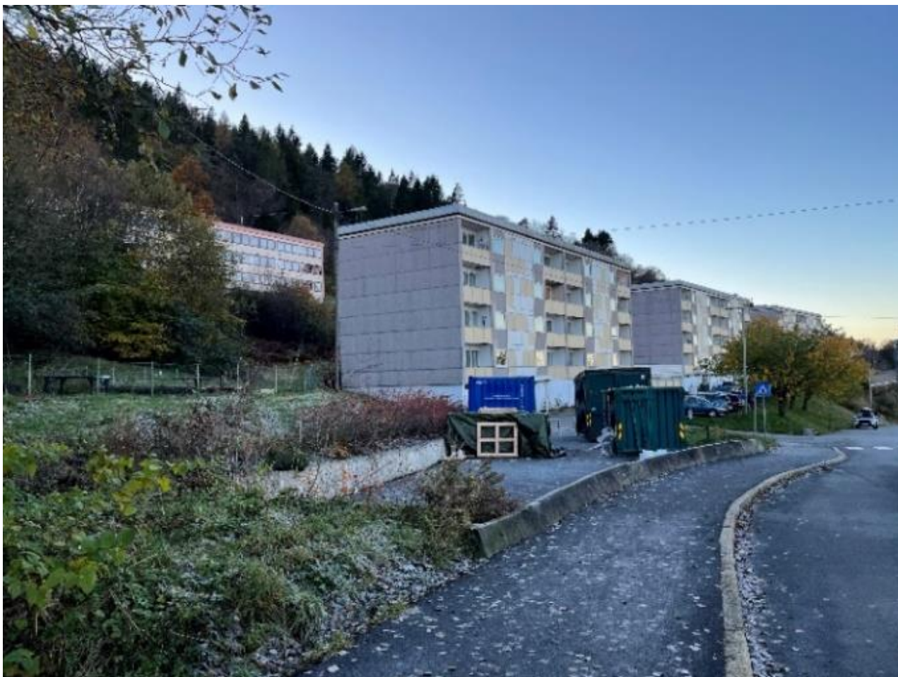
Figur 15: Bildet viser grøntarealet og parkeringsplassen i tilknytning til Gyldenprisveien 49, som vurderes som midlertidig rigg- og anleggsområde. Foto: Norconsult, oktober 2023.
