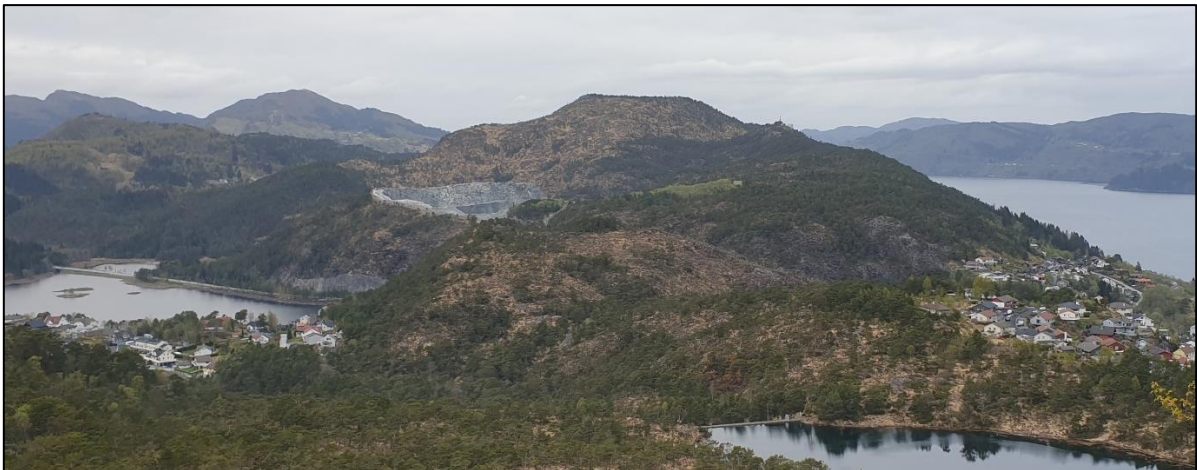
Figur 1 Steinknuseverket. Bildet er tatt i retning nord fra fjelltoppen Sjurstonipa. Foto: M. Bjerga, Multiconsult.
