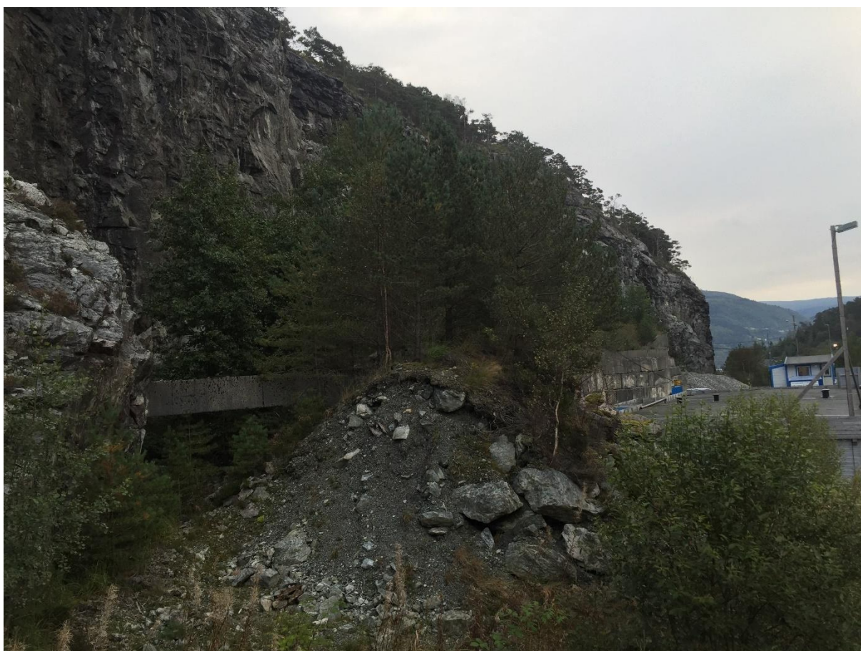
Figur 12: Skredvull etablert ved utkjøringen fra steinbruddet.
