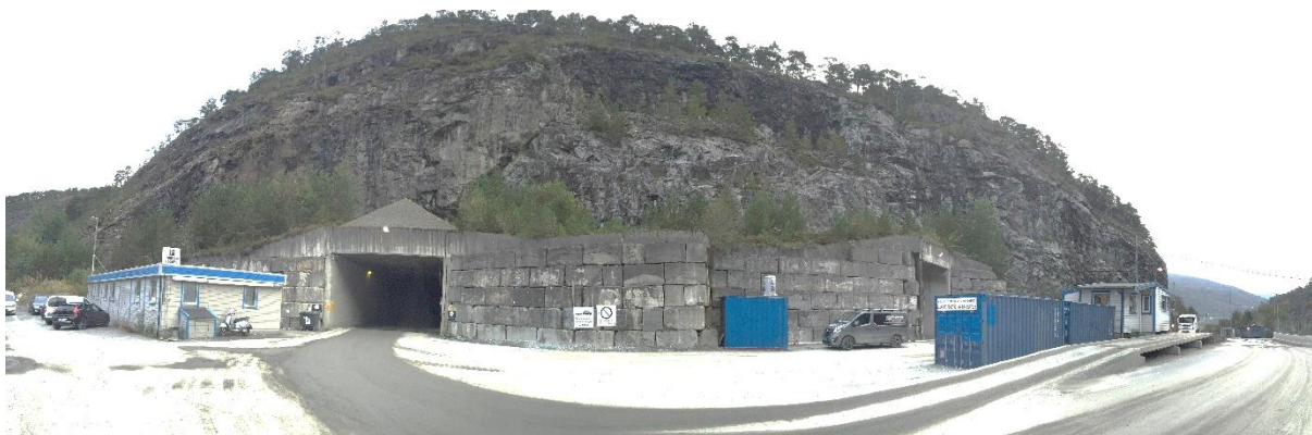
Figur 9: Oversikt området ved område BN2, kontor- og administrasjonsbygg.
