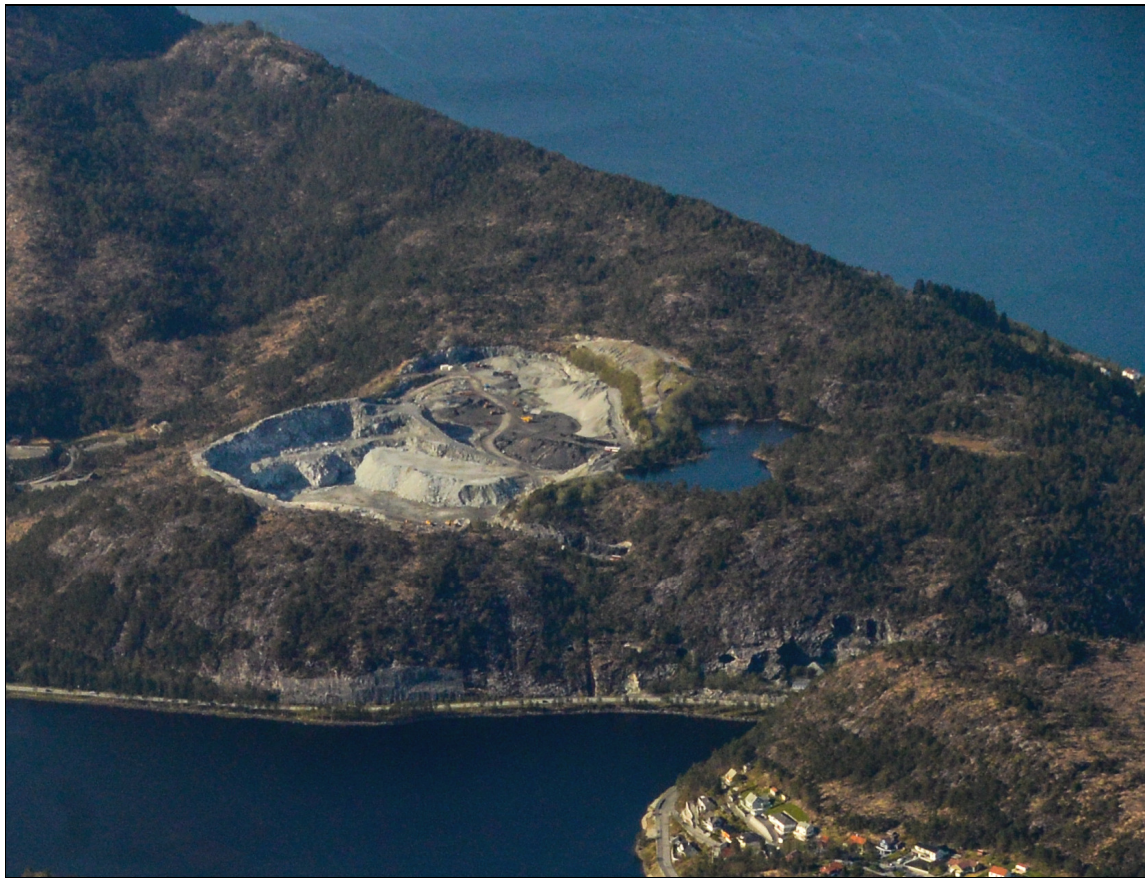
Figur 2. Arna Steinknuseverk pr. mai 2015. Til høyre for steinbruddet ligger Liatjørna, i forgrunnen Gaupåsvatnet, og bakerst Sørfjorden, hvor utskipingskai skal anlegges. Foto: Geir Helge Johnsen.
