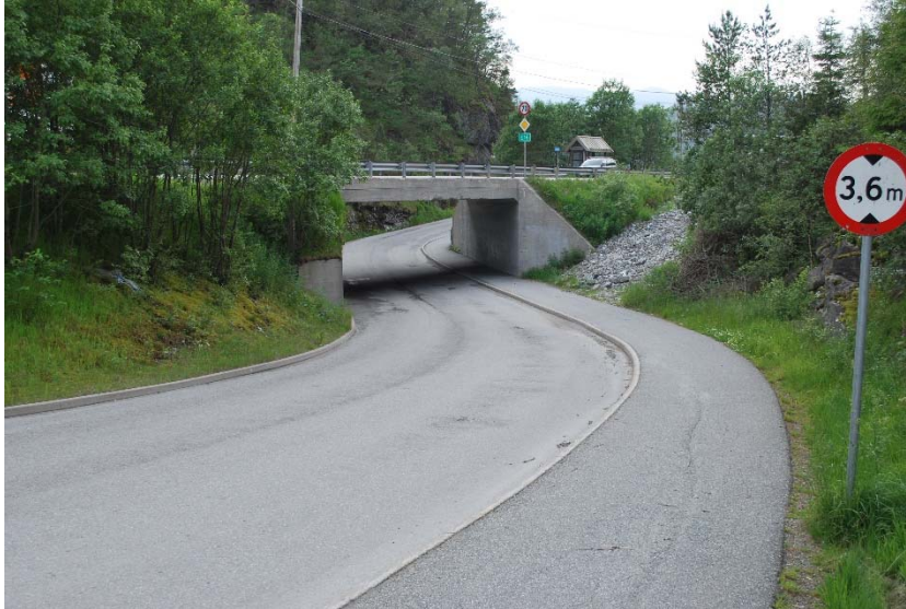
Figur 7: Bildet viser Gaupåsvegen som ligger i kulvert under E16.
