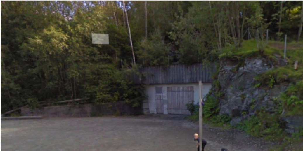
Bilde 2: Adkomst til avløpstunnel.
