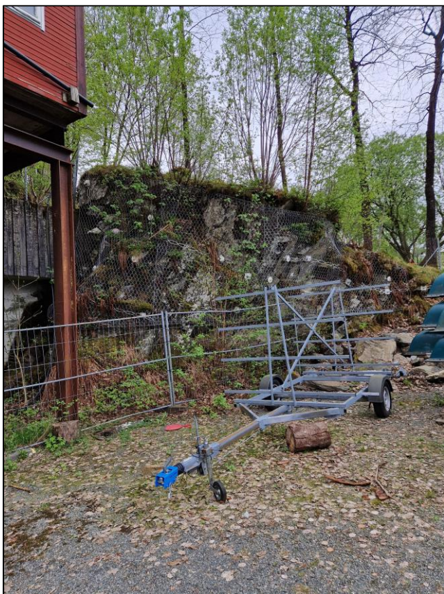
Foto 1. Eksisterende sikringstiltak ved Harald Skjolds veg 30.
