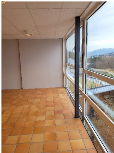
Bilde 3 Innvendig stålsøyle
