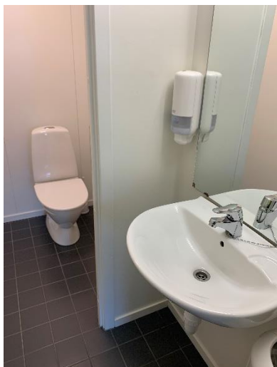
Bilde 11 Servant og toalett i Fløy A-C, antatt å være fra nyere tid enn 1997/1999
