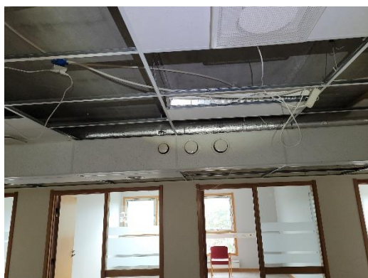
Bilde 1 Deler av synlig hulldekke over himling
