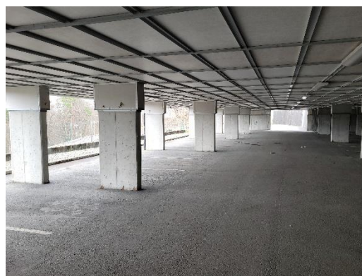
Bilde 2 Betongkonstruksjoner parkering
