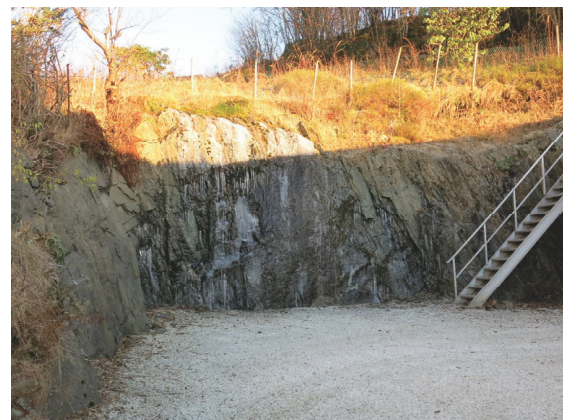
Dagens situasjon mot skjæring
