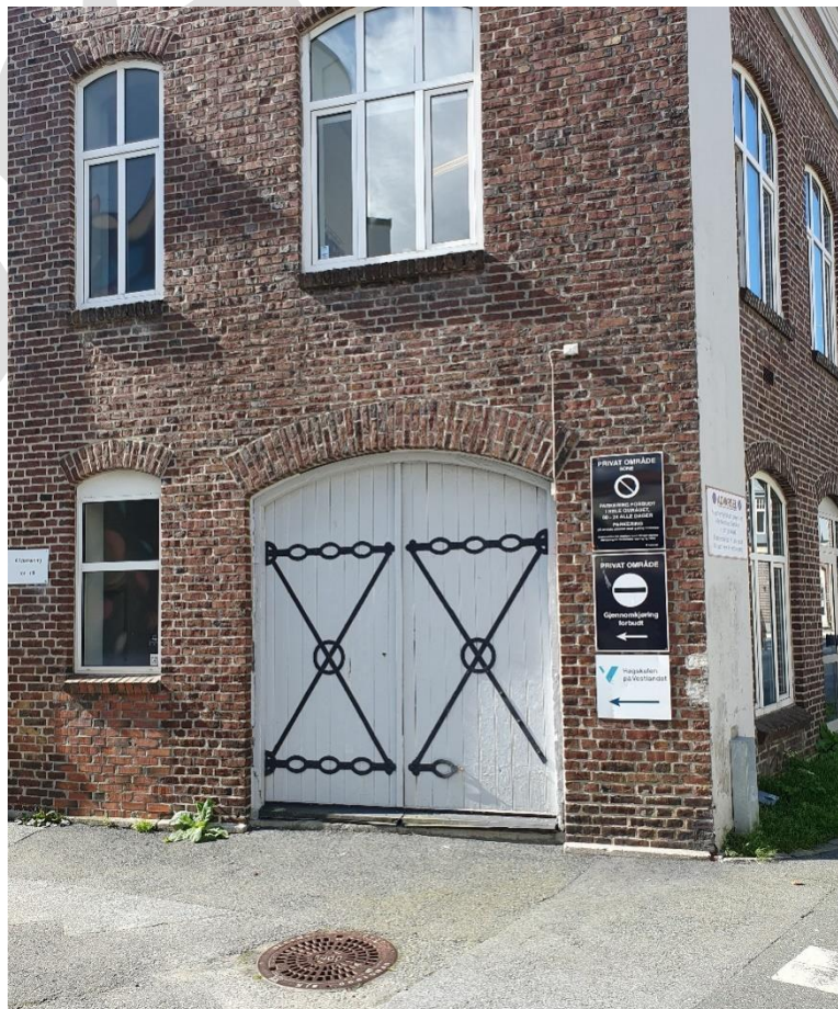
Figur 4-5. Fasadene langs o_GT i Fabrikkgaten 5.
