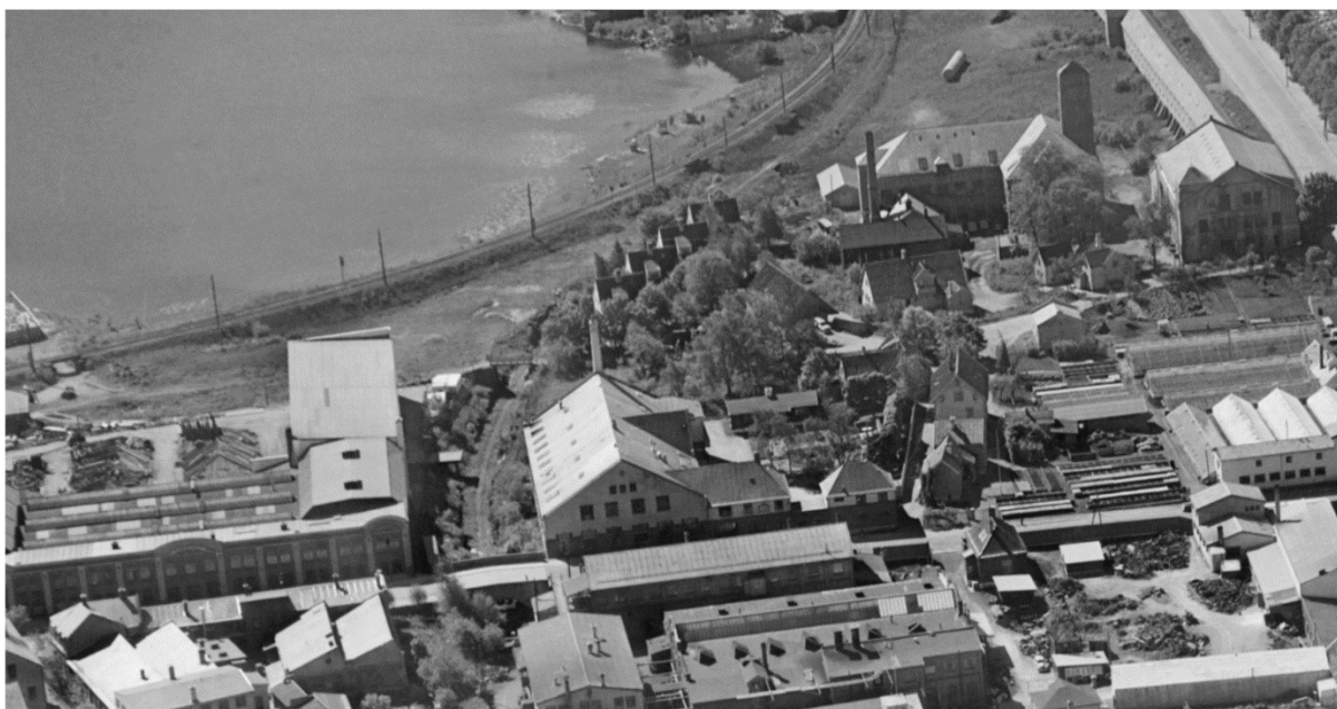
Figur 3-7. Bildet viser jernbanesporet slik det opprinnelig lå i skjæring frem til 50-tallet. Legg merke til at sporet går i kulvert under Fabrikkgaten. NSBs lokomotiv type 18, som ble brukt på Bergensbanen, har skorsteinshøyde på 4,1 meter. Kilde: Marcus.
