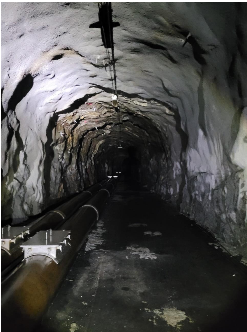
Figur 4 Vannledninger/avløpsledninger langs sålen i tunnelen mellom trapp og nisje (Tunnel S)
