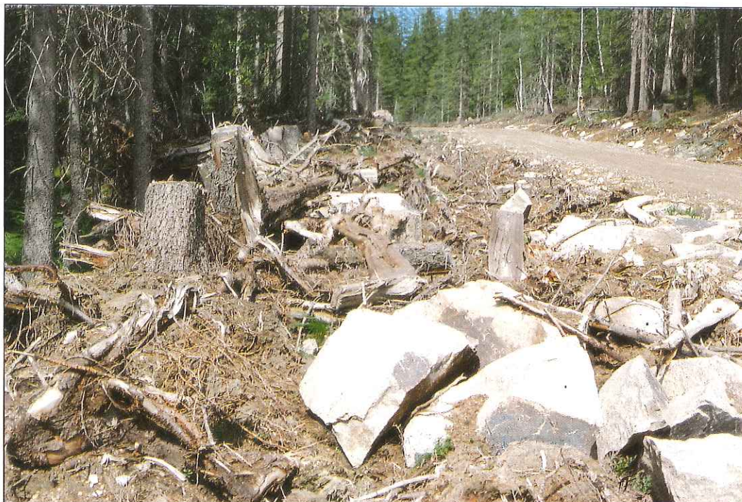
Bilde 9 Utgravde skjæringsmasser skal tilpasses terrenget. De skal ikke være til hinder når mennesker og maskiner skal ut i tilstøtende areal.
