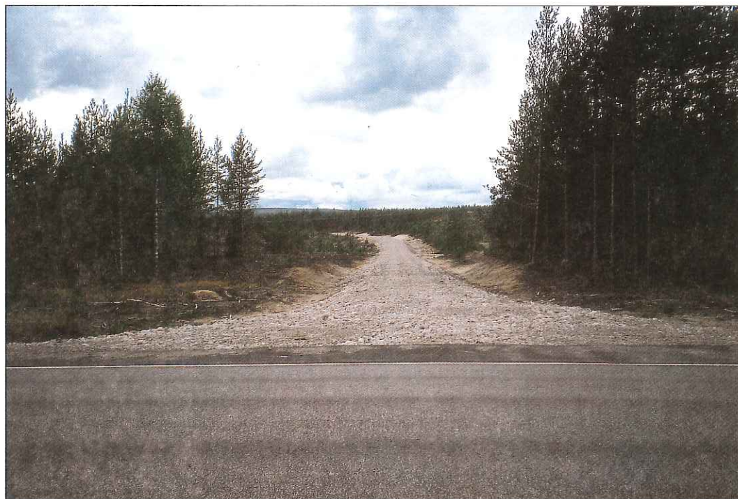
Bilde 2 Ved avkjørsel fra offentlig vei eller hovedvei bør det legges inn en kurve eller overgangskurve i kort avstand fra avkjørselspunktet. Det er ikke ønskelig med en lang rettstrekning vinkelrett på hovedveien.
