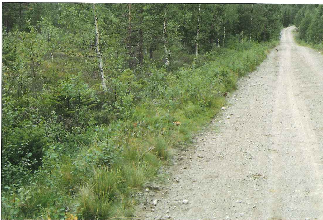
Bilde 25 Fjerning av kratt er et nødvendig vedlikeholdstiltak som må planlegges og utføres med 3-4 års mellomrom. Eksisterende vegetasjon vil dermed være med å føye veien inn i dens naturlige omgivelser.
