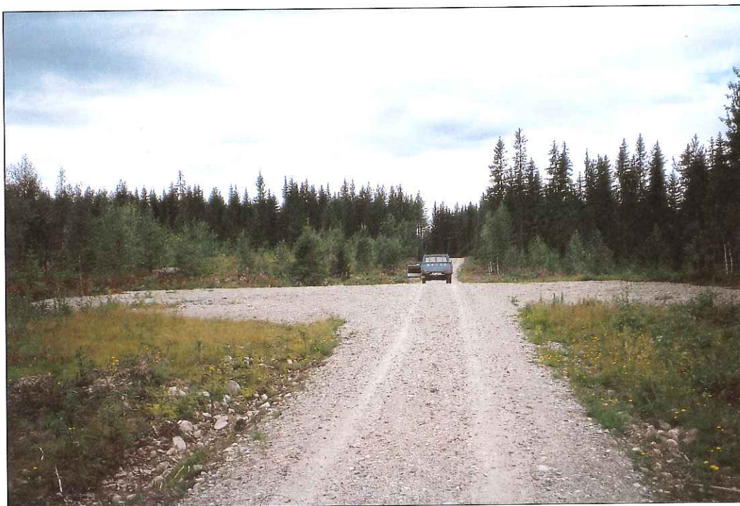
Bilde 19 På flate morenemarker med gode dreneringsforhold kan grøft utelates når veien ligger høyere enn tilstøtende terreng
