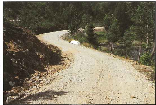
Bilde 15 og 16 Ved å unngå plassering av fyll- og skjæringsmasser på yttersiden av ytterkurver vil veiens inngrep virke langt mer moderat og terrengtilpasset.
