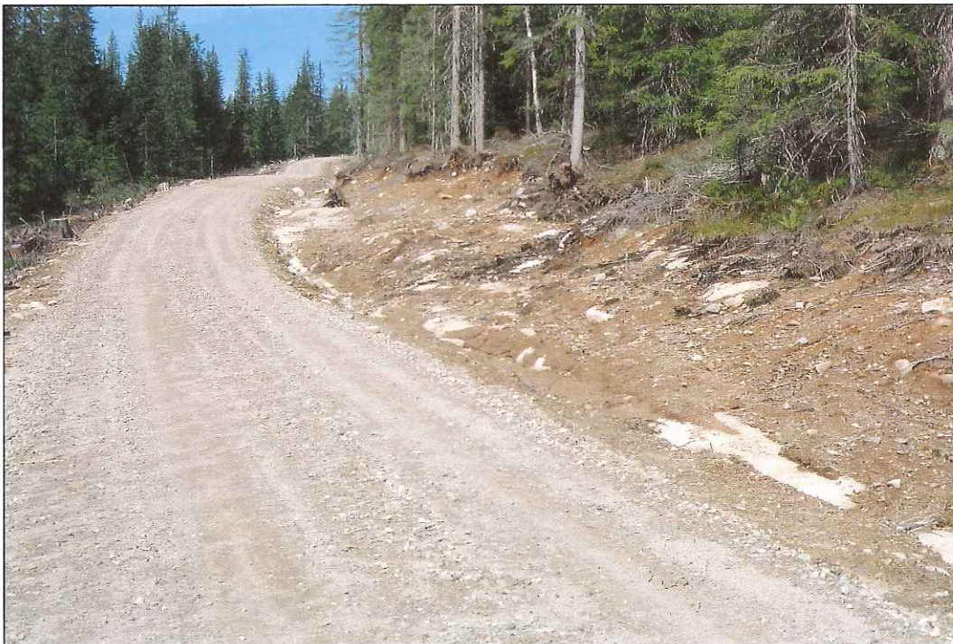
Bilde 5 Hvis tilgjengelige løsmasser blir tatt ukritisk fra nærliggende områder på sidene av veibanen, vil dette skape store sår i terrenget. Dette kan ha langt sterkere negativ virkning enn selve veien.
