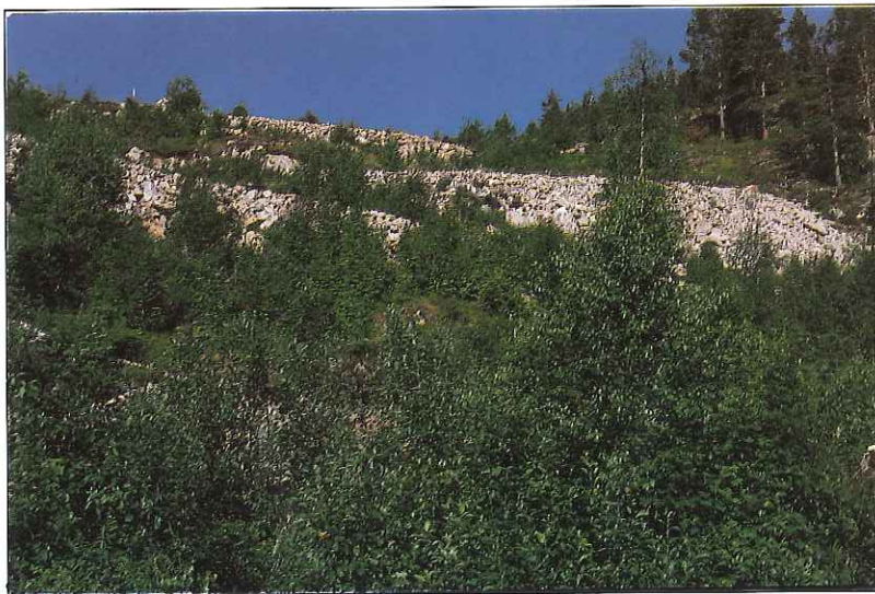
Bilde 17 og 18 Vendekurver bygd opp av steinfyllinger bør påkjøres løsmasser hvis innsyn tilsier dette.
