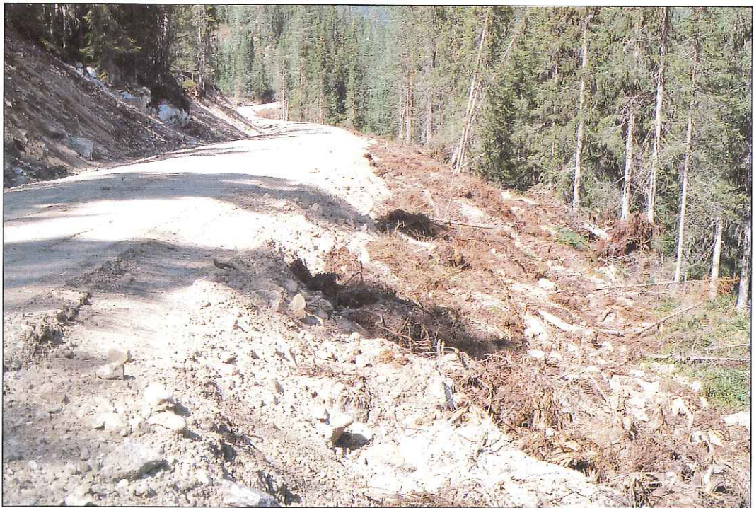
Bilde 22 Eventuelle overskuddsmasser langs utsiden av veien skal planeres til et nivå under kjørebanelen og skrånnes ned mot tilstøtende terreng.
