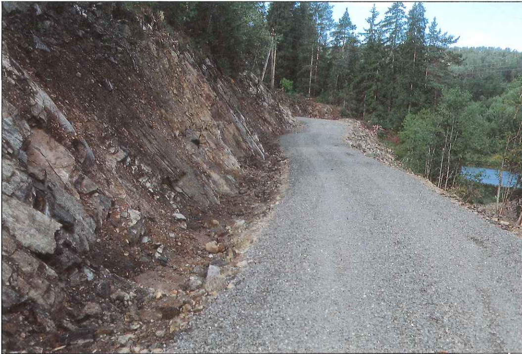
Bilde 4 Øvre skjæringskant skal avlastes og renses for utoverhengende humus, undergravde stubber, røtter og stein som ikke forblir stabile. Bortsett fra denne nødvendige rensk skal humuslaget utenfor naturlig skjæringstopp og fyllingsfot bevares uforstyrret.
