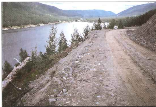
Bilde 15 og 16 Ved å unngå plassering av fyll- og skjæringsmasser på yttersiden av ytterkurver vil veiens inngrep virke langt mer moderat og terrengtilpasset.
