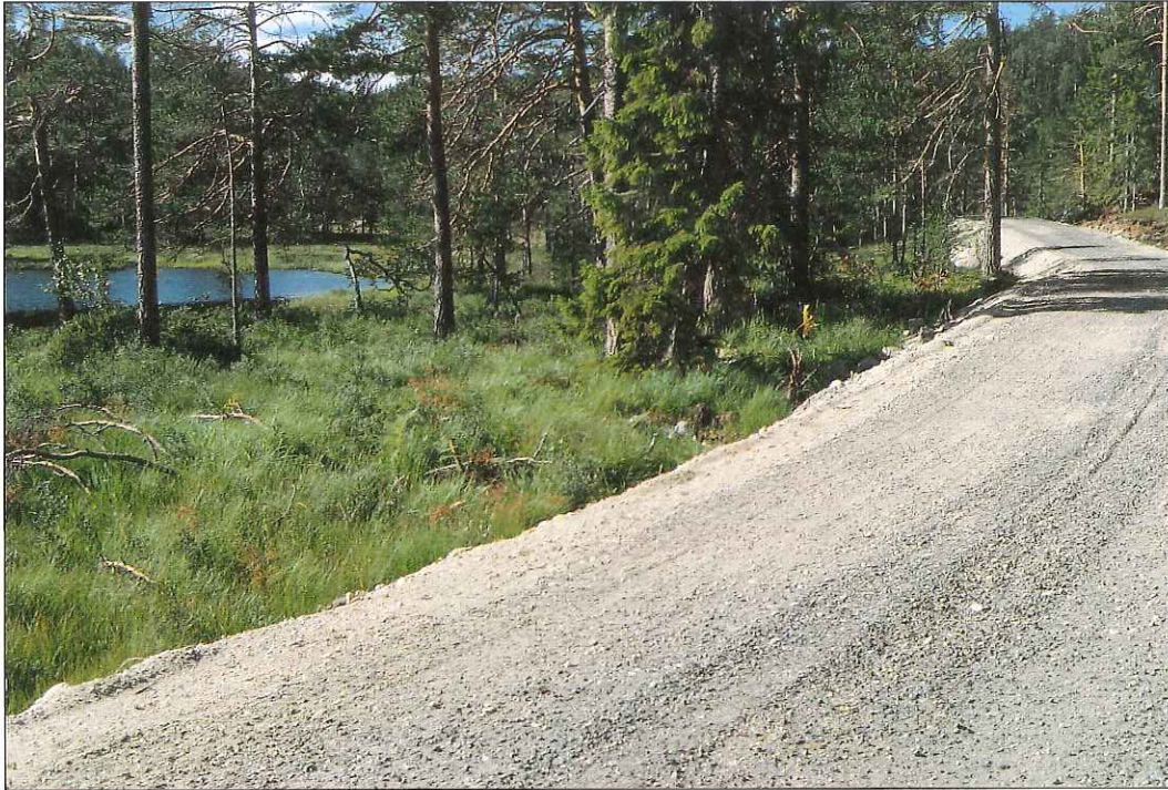
Bilde 1 Langs strandlinjer bør veitraséen legges i god avstand fra vannet. Beltet mellom fyllingsfot og strandlinje (min. 20-30 m) bør ha mulighet for variert vegetasjon.
