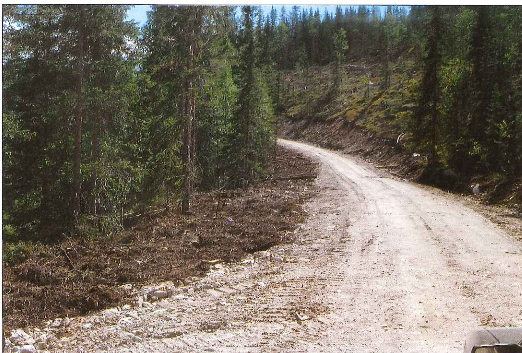
Bilde 10 Massene skal planeres ut til et nivå som ligger lavere enn veibanen og tilpasses tilstøtende terreng. Alternativt kan massene jevnes ut over fyllingsfot og dermed redusere uheldig innsyn. Eventuelle avfallsmasser kan også benyttes på samme måte (skråningsutslaking).
