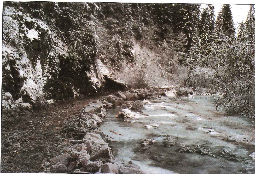
Bilde 31 Overskuddsmasser fra en traktorvei må også behandles slik at terrenget ikke påføres miljømessige skader og gir negativt visuelt inntrykk.
