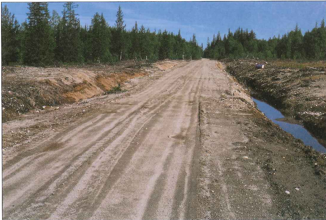
Bilde 8 I miljøsammenheng er overdimensjonering uønsket. Teknisk er det også uheldig. Brede grøfter skaper store problemer for tømmertransporten
