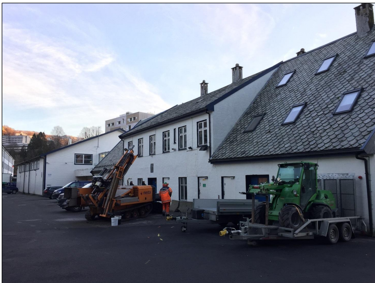
Figur 1. Oversikt over tiltaksområdet for Kanalveien 8 med borerigg fra Mesta på BP-7
