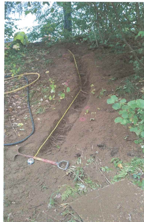
Grøft med slutt punkt ved parkeringsplass
