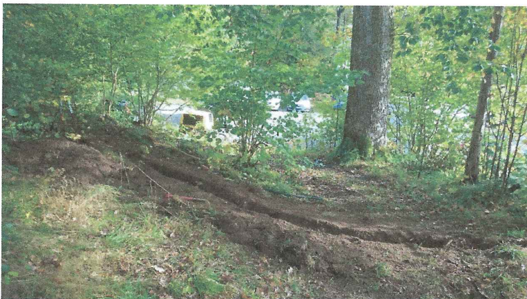
Grøft med startpunkt (nullpunkt)
