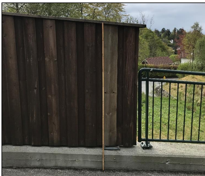
Figur 3. 2,0 m støyskjerm langs Birkelundsbakken med overgang til gjerde. Betongkanten er ca. 25 cm.
