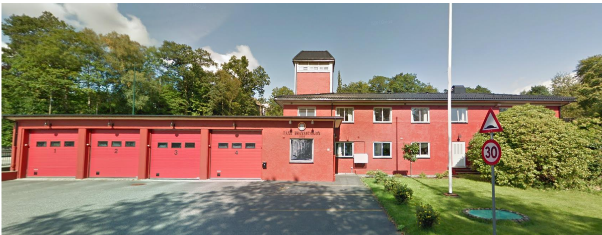
Figur 8 Brannstasjonen sett fra Sandbrekkevegen.
