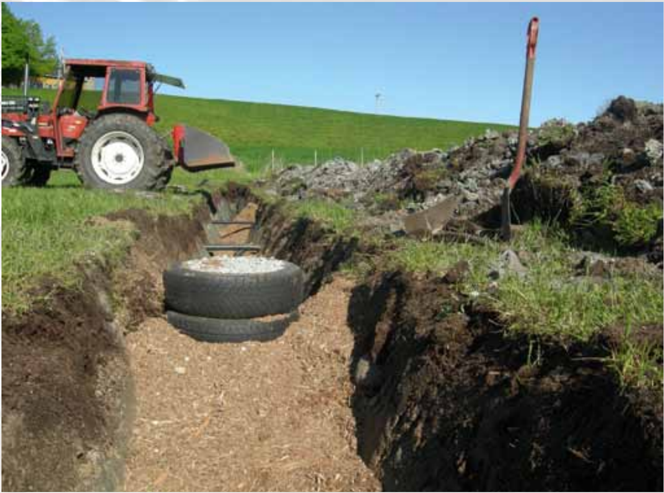
Enkle nedløpskummar laga av bildekk og singel. Foto: Leif Trygve Berge.
