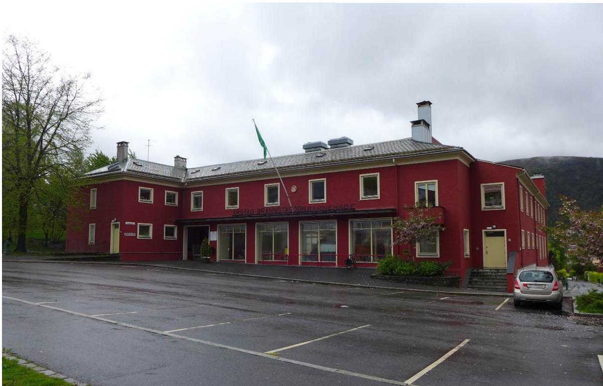
Figur 6: Stasjonens fasade mot øst. De opprinnelige garasjeportene er skiftet ut med store vinduer i de samme åpningene (Foto: Bergen kommune, Byantikvaren 2015).
