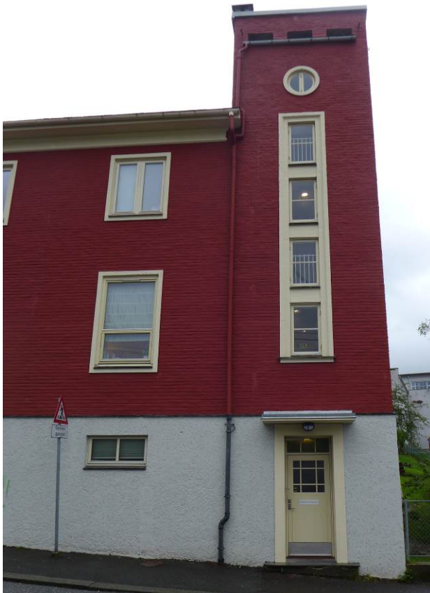
Figur 4: Trappehuset lengst mot nordøst. Vinduene er gamle, mens døren er en kopi av den originale døren, som måtte skiftes ut (Foto: Bergen kommune, Byantikvaren 2015)
