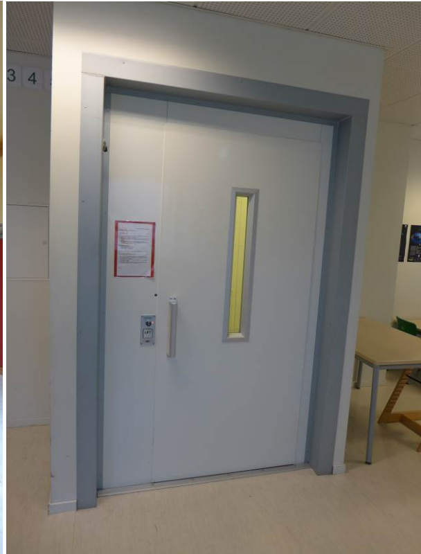
Figur 20: Bygningen har fått heis i forbindelse med ombygging til barnehage (Kilde: Bergen kommune, Byantikvaren 2015).
