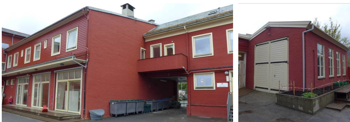
Figur 9: (over) Bygningens nordfløy sett fra bakgården. Det avlange vinduet over inngangen synes ikke å være i opprinnelig åpning, men resten av fasaden har bevart opprinnelige vindusåpninger med nye vindu. (venstre) I østfløyens fasade mot bakgården er det satt inn vinduer i de gamle garasjeportene. (høyre) Verkstedet med gamle vindu og restaurert port (Kilde: Bergen kommune, Byantikvaren 2015).
