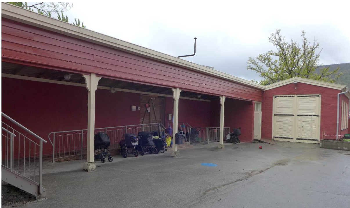
Figur 10: Det overdekte skuret mot sør har fine, historiske bygningsdetaljer. Porten ble satt inn i forbindelse med omleggingen til barnehage. Lengst til høyre er verkstedet og døren inn til smia. Under smia ligger tilfluktsrommet (Kilde: Bergen kommune, Byantikvaren 2015).
