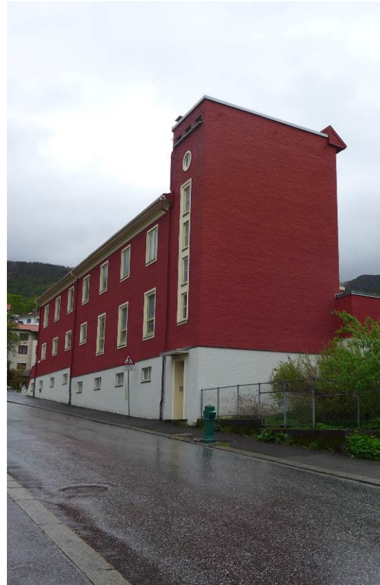
Figur 5: Foto av Brannstasjonens nordfløy, med trappehuset nærmest i bildet. Et tilbygg langs trappehusets vestside fra 1984 ble ikke realisert (Foto: Bergen kommune, Byantikvaren 2015).
