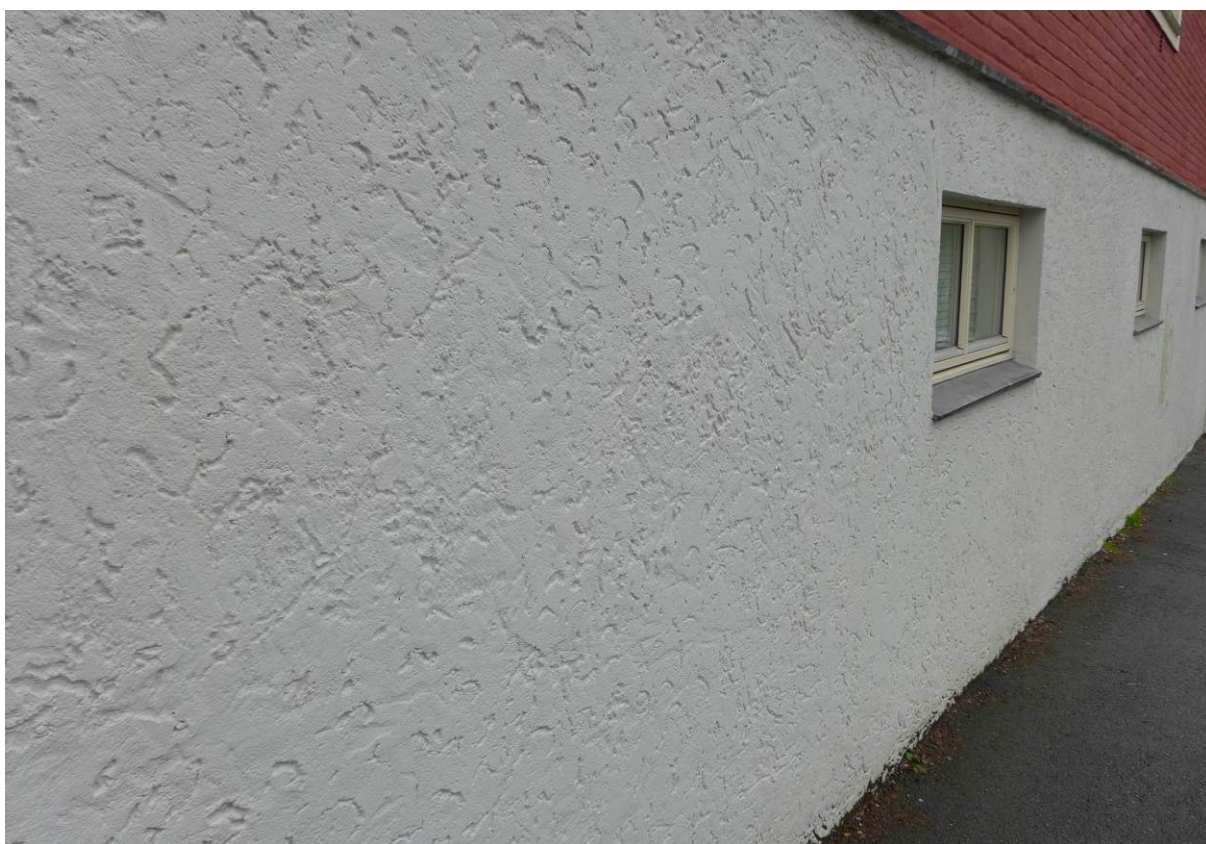
Figur 11: Bilde av grunnmurens mått-puss. Alle vinduskarmer har sålbenk av skifer (Kilde: Bergen kommune, Byantikvaren 2015).
