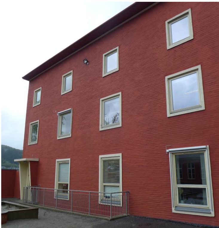
Figur 8: Bygningens nordfløy sett fra bakgården. Det er nye vinduer i opprinnelige åpninger i fasaden (Kilde: Bergen kommune, Byantikvaren 2015).
