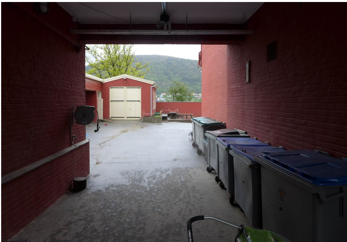
Figur 25: Gjennom bygningens østfløy leder det en gang/portrom inn til bakgården, som i dag fungerer som lekeareal for barnehagen (Kilde: Bergen kommune, Byantikvaren 2015).
