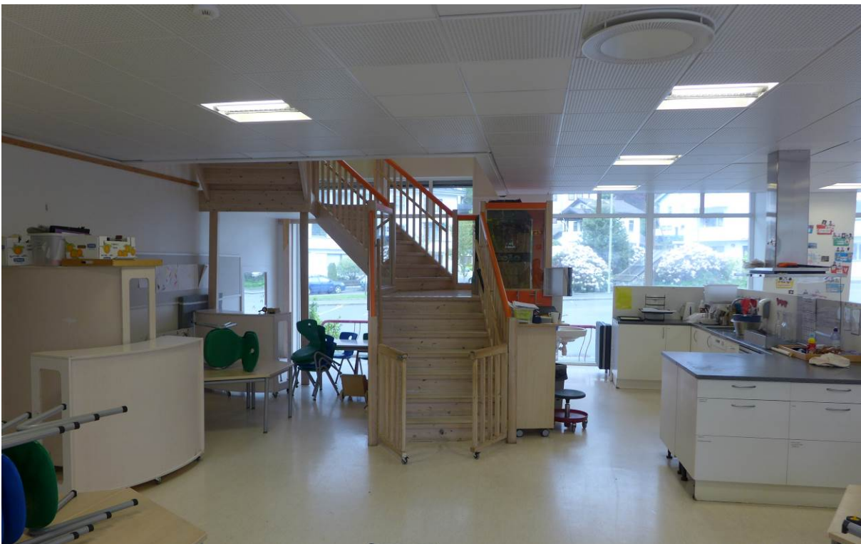
Figur 21: Ved ombyggingen til barnehage ble den opprinnelige garasjen gjort om til oppholdsareal med store vinduer i de originale garasjeportåpningene. Det ble også satt inn en ny trapp (Kilde: Bergen kommune, Byantikvaren 2015).
