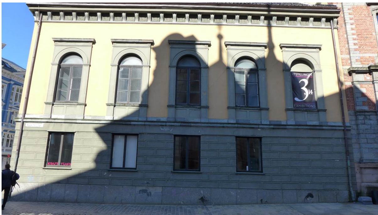
Figur 5. Fasade mot vest hvor vinduene i sokkeletasjen er endret (Foto: Byantikvaren 2015).
