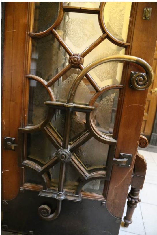
Fig 9. Detalj av dør. Fra Schak Bulls ombygging 1925-27 (Foto Byantikvaren 2015).
