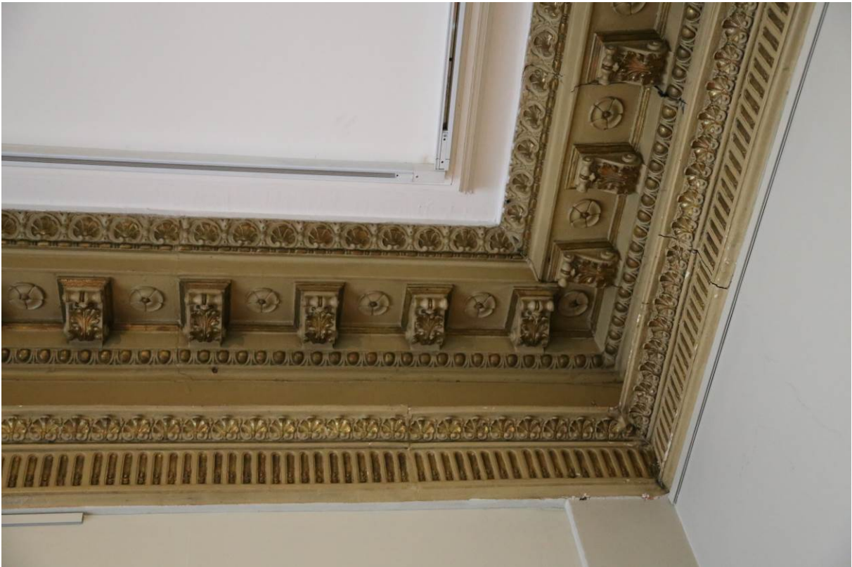
Fig 12. Profilert listverk i taket med gullforygging. Er sannsynligvis opprinnelig (Foto: Byantikvaren 2015).
