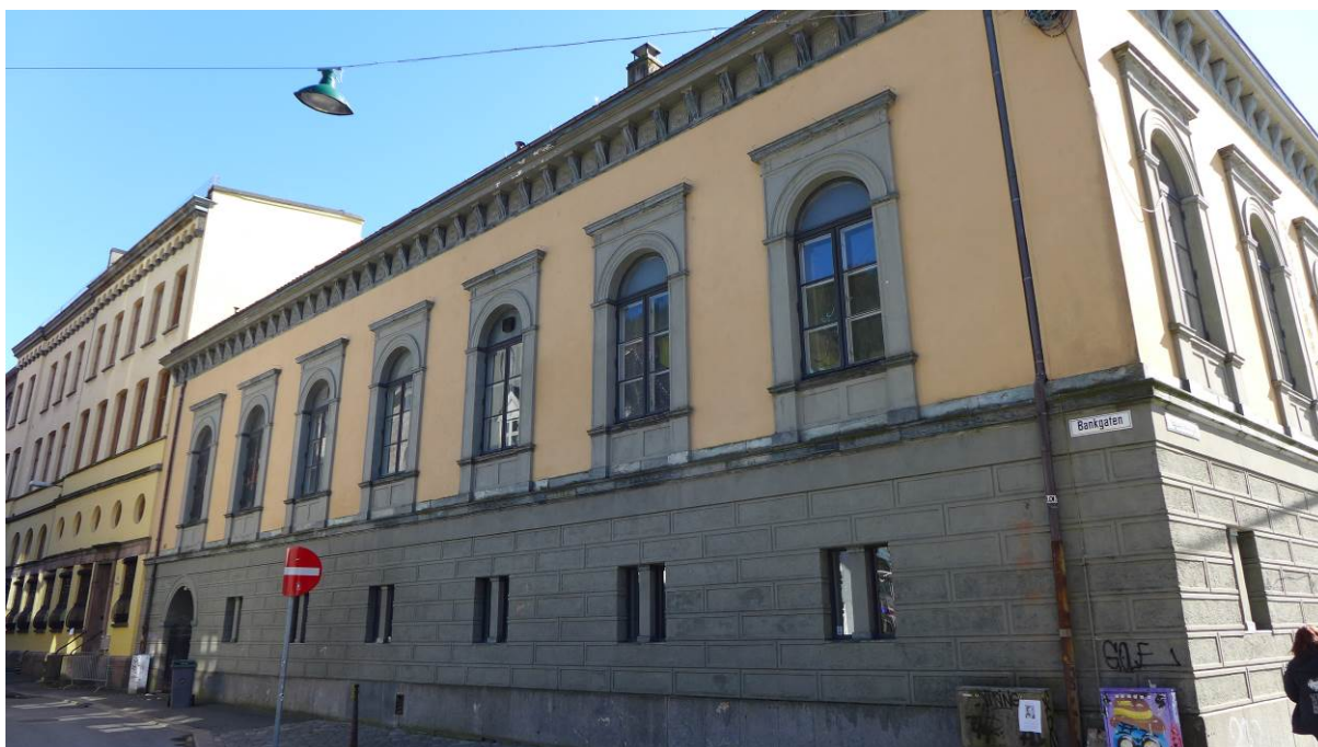
Figur 6. Fasade mot øst hvor det er mulig å se spor i muren etter dørens midtstilte plassering (Foto: Byantikvaren 2015).
