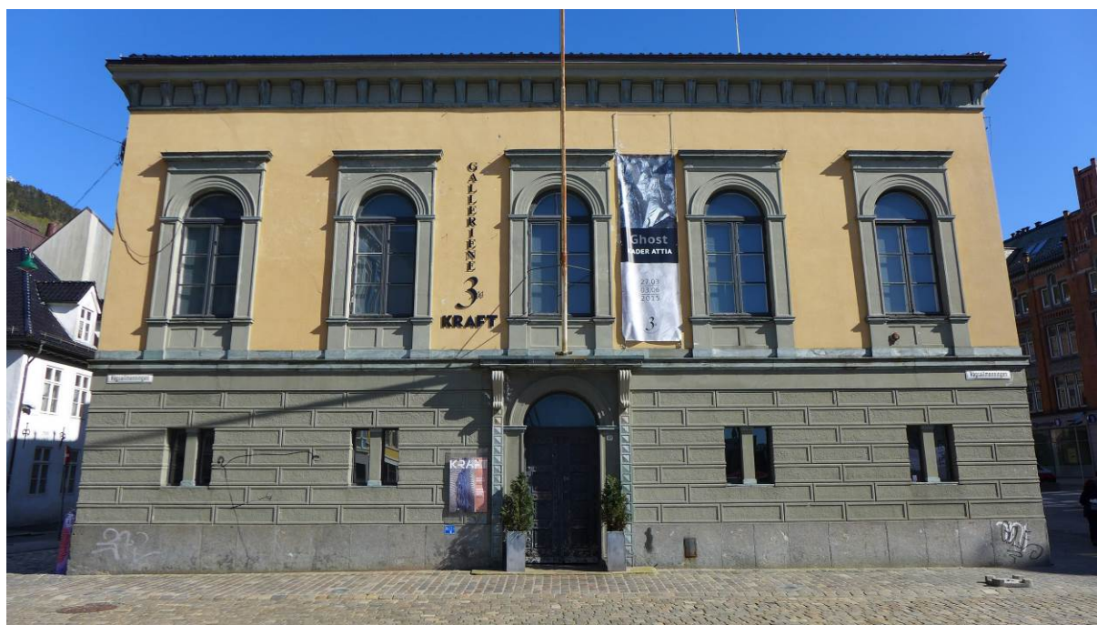
Figur 4. Hovedfasaden mot nord har fire små vinduer i sokkeletasjen som understreker den lukkede og uinntagelige bankbygningen (Foto: Byantikvaren 2015).
