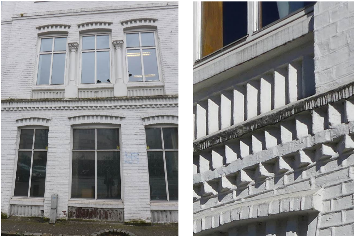
Figur 16: Til venstre: I andre etasje er det to søyler som opprinnelig markerte midtgavlen på den nygotiske villaen fra 1880. Til høyre: Dekorativt murverk med høyt relieff (Foto: Byantikvaren 2015).
