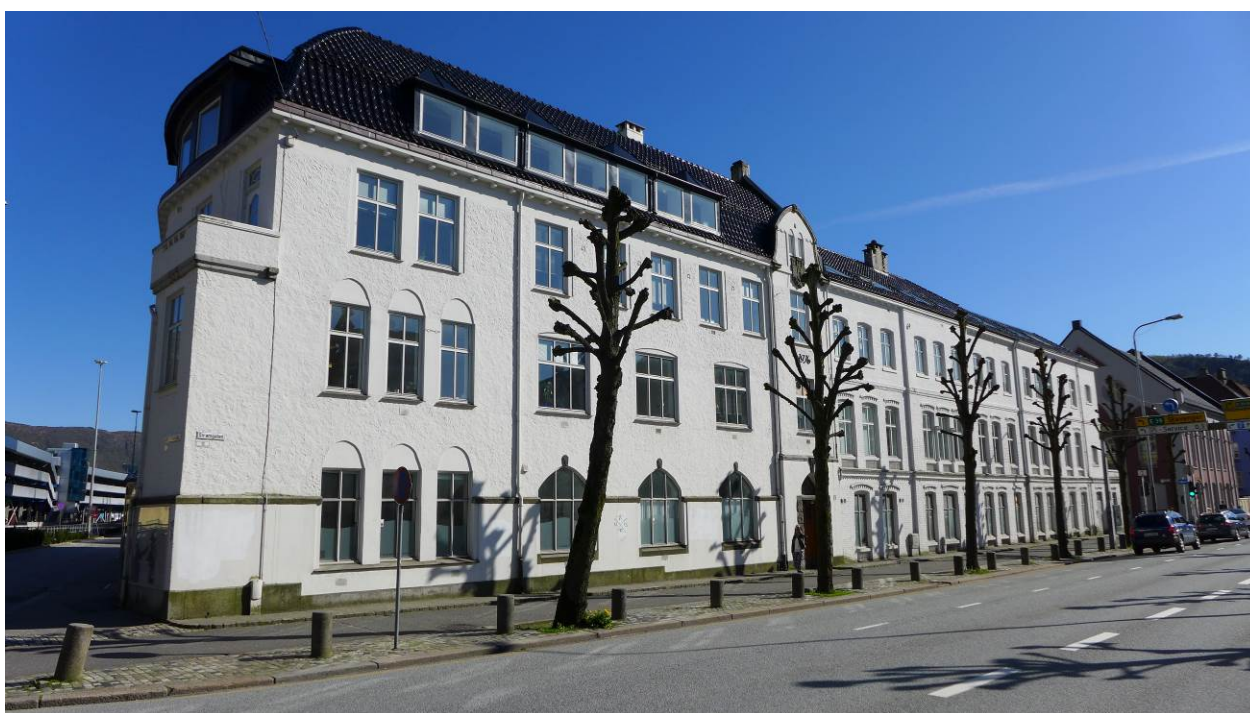
Figur 18: Strømgaten 10 slik den fremstår i dag, et vellykket eksempel på sammenbygging. Til venstre i bildet er karnappet med altan, altandøren er trolig original (Foto: Byantikvaren 2015).
