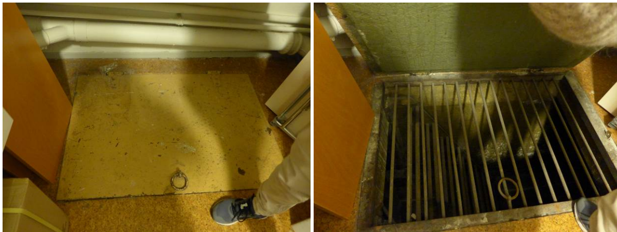
Figur 23: Bildene over viser nedgangen til fyr-rommet (Kilde: Foto, Byantikvaren 2015).
