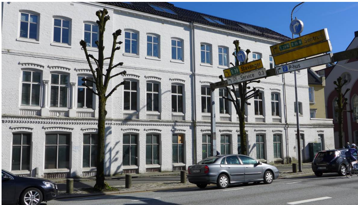
Figur 15: Bygningene som delvis er fra 1880-tallet. Fasade mot Strømgaten, bygget på til 3 etasjer i 1946 med rekker av svakt buede vindusåpninger (Foto: Byantikvaren 2015).
