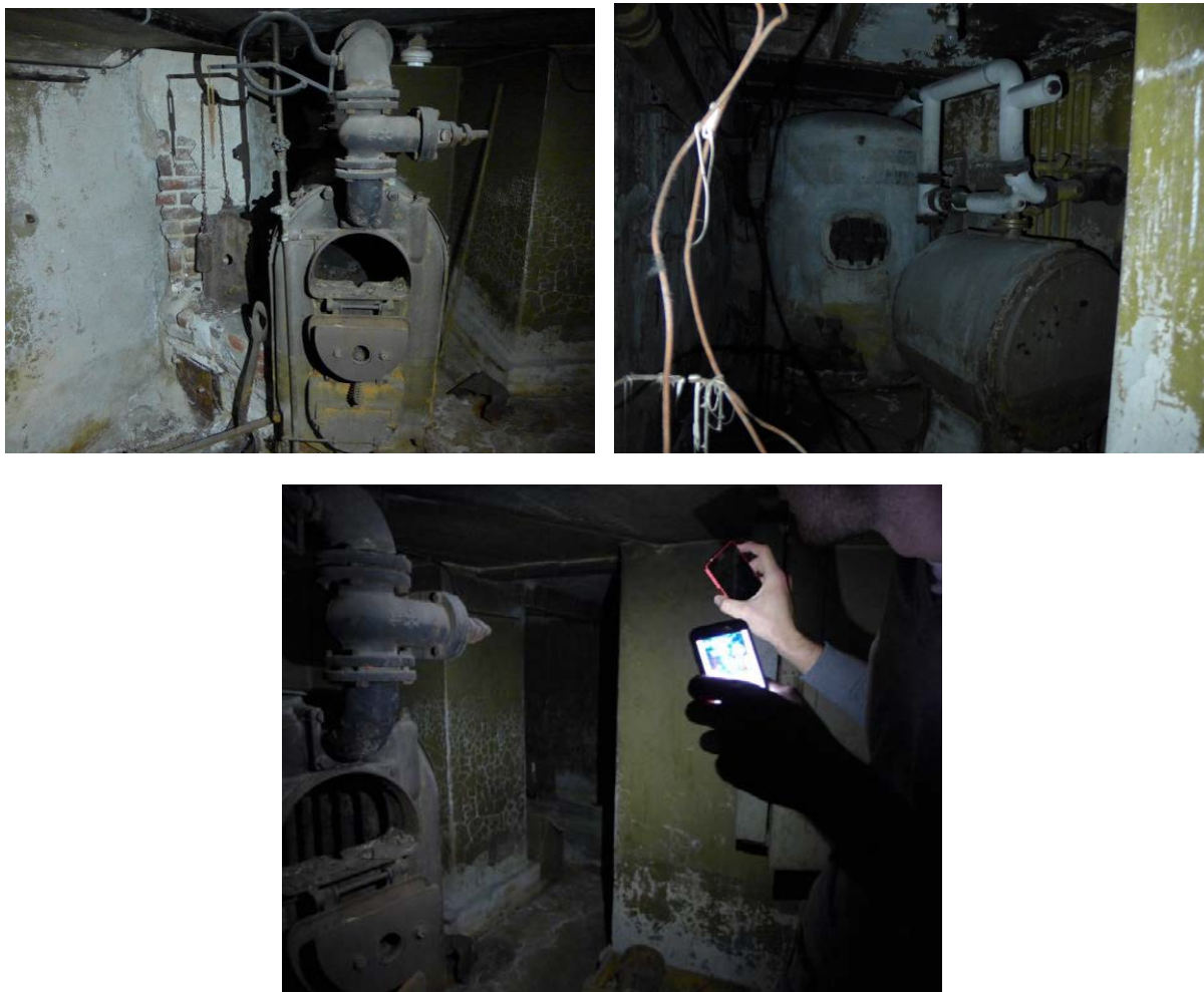
Figur 24: De tre bildene viser fyr-rommet i kjelleren, under gårdsplassen. Legg merke til de solide murveggene (Foto: Byantikvaren 2015).
