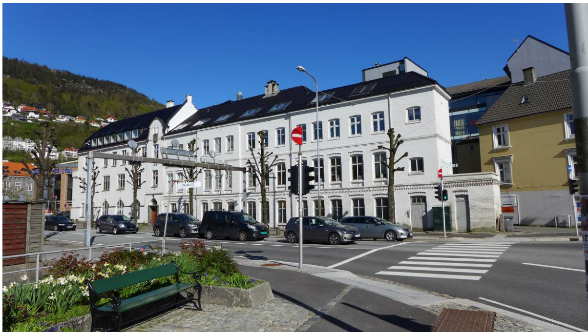
Figur 14: Strømgaten 10 (Foto: Byantikvaren 2015).
