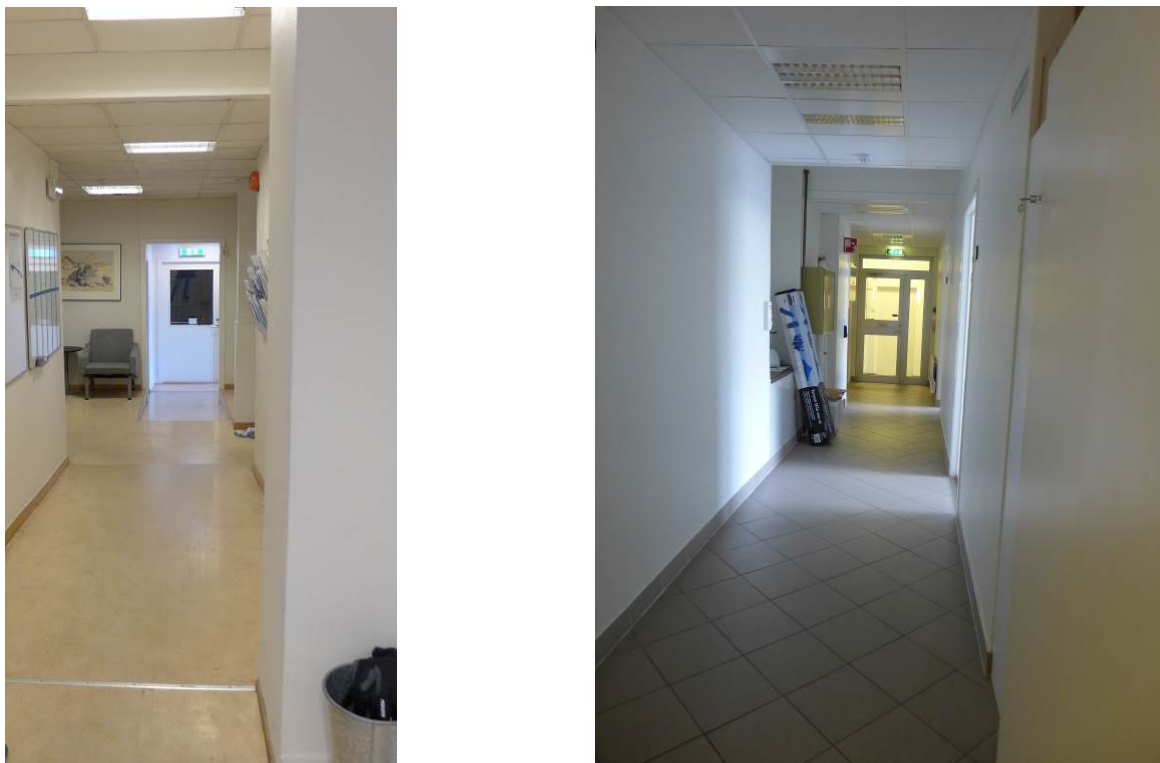
Figur 25: Overgangen mellom bygningen fra 1916 og det eldste bygget. Det er nivåforskjell i gulvet, og tykke solide murer markerer skiller mellom byggene. Bildet til høyre viser nyere innredning/ombygging (Foto: Byantikvaren 2015).
