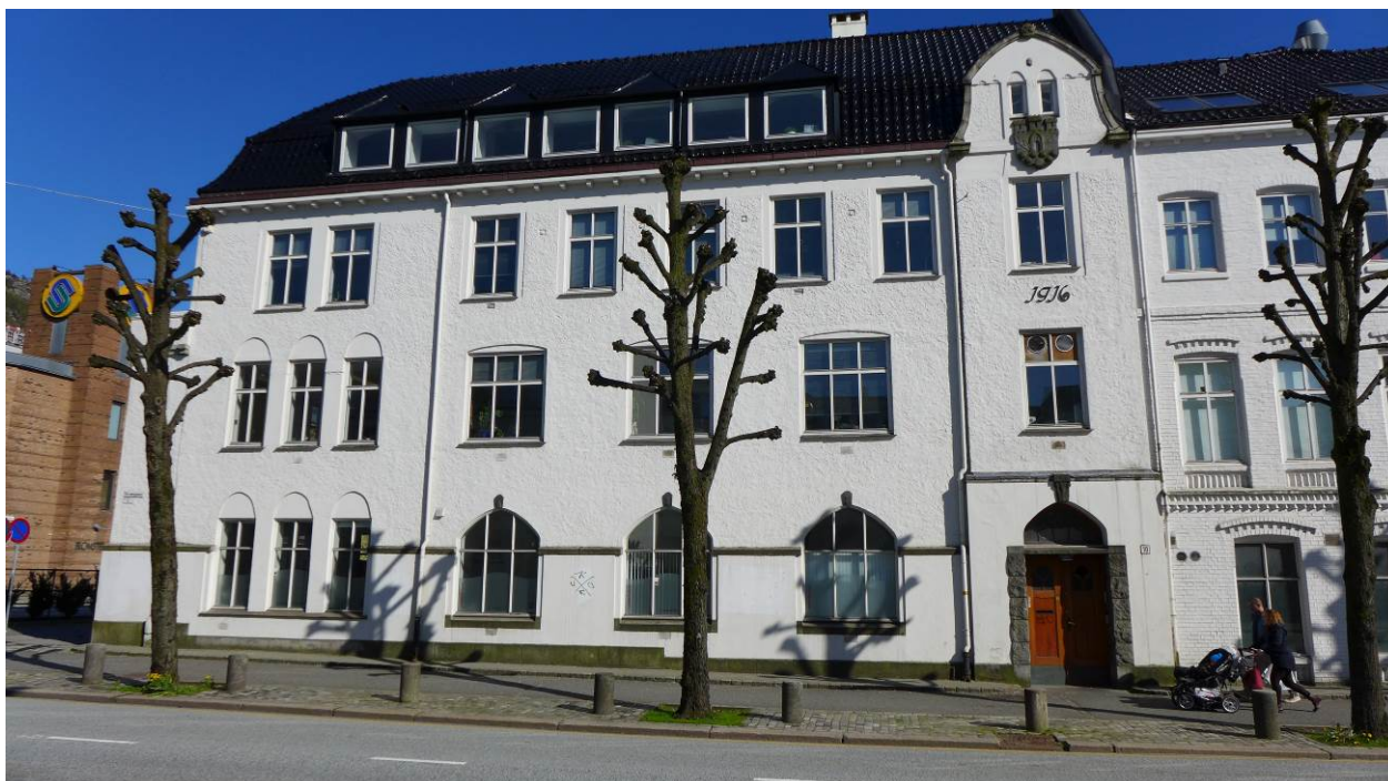
Figur 17: 1916-bygningen i nordisk nybarokk. Fasaden mot strømgaten har inngangspartiet lagt til høyre, markert i fasaden med et gavloppbygg. (Foto: Byantikvaren 2015).
