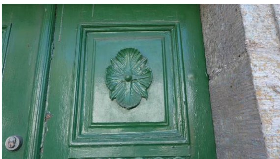
Figur 7. Detalj fra døren i hovedportalen (Foto: Byantikvaren 2015).
