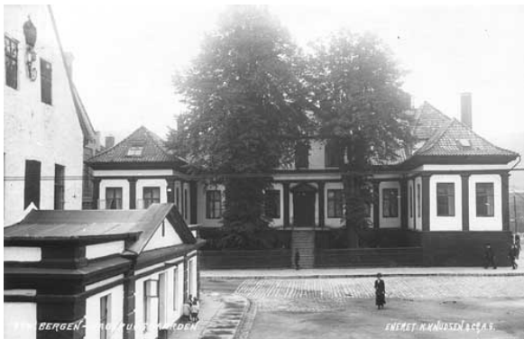
Figur 2. Historisk foto av frontfasaden til Hagerupsgården, med Gamle rådhus i forgrunnen, i 1917 (Kilde: UBB-KK-0814_1917-20_K_Knudsen).
