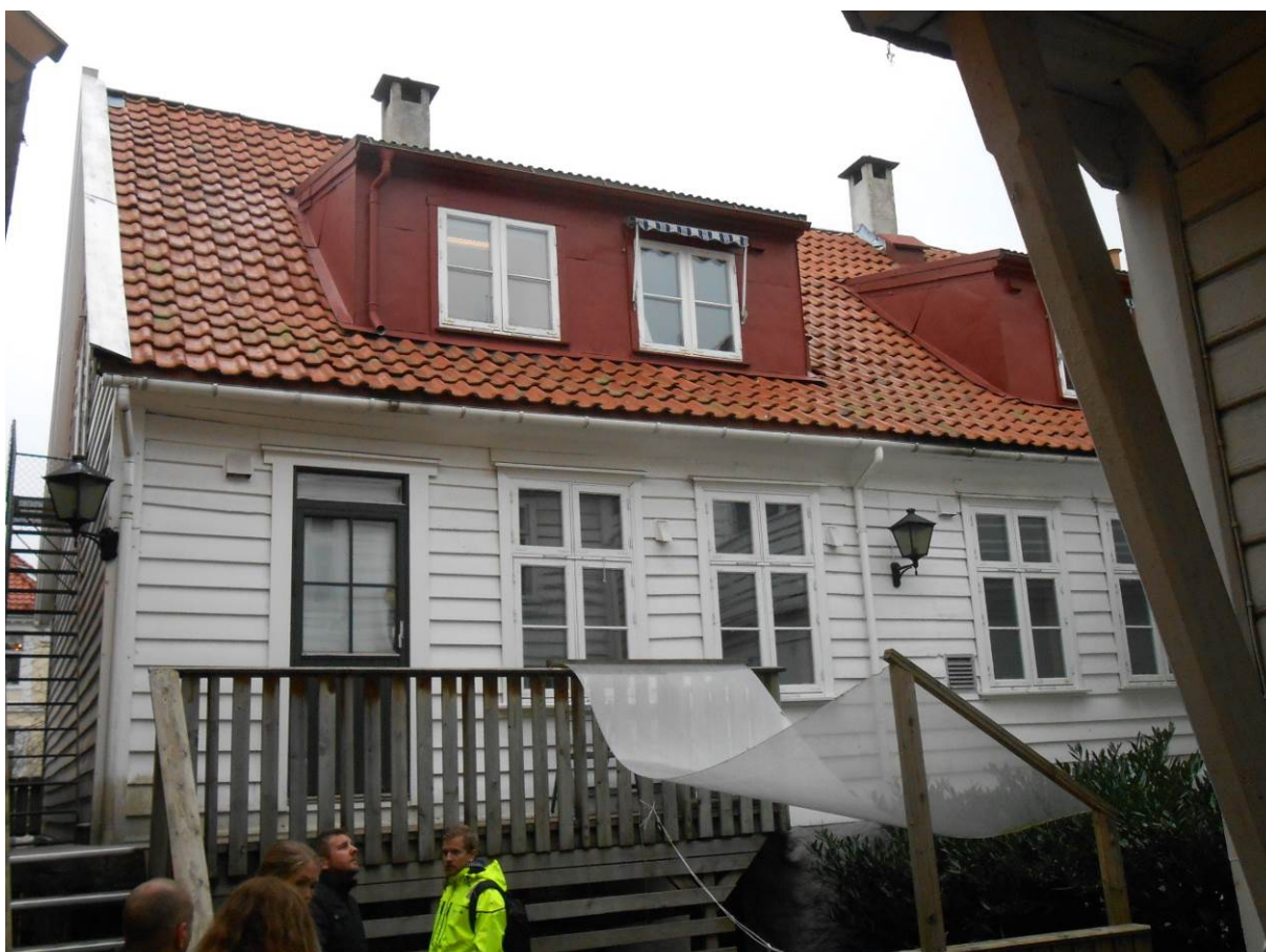
Figur 8. Baksiden av huset mot sørøst med to inntrukne og beslåtte takopplett (foto: Byantikvaren 2015).
