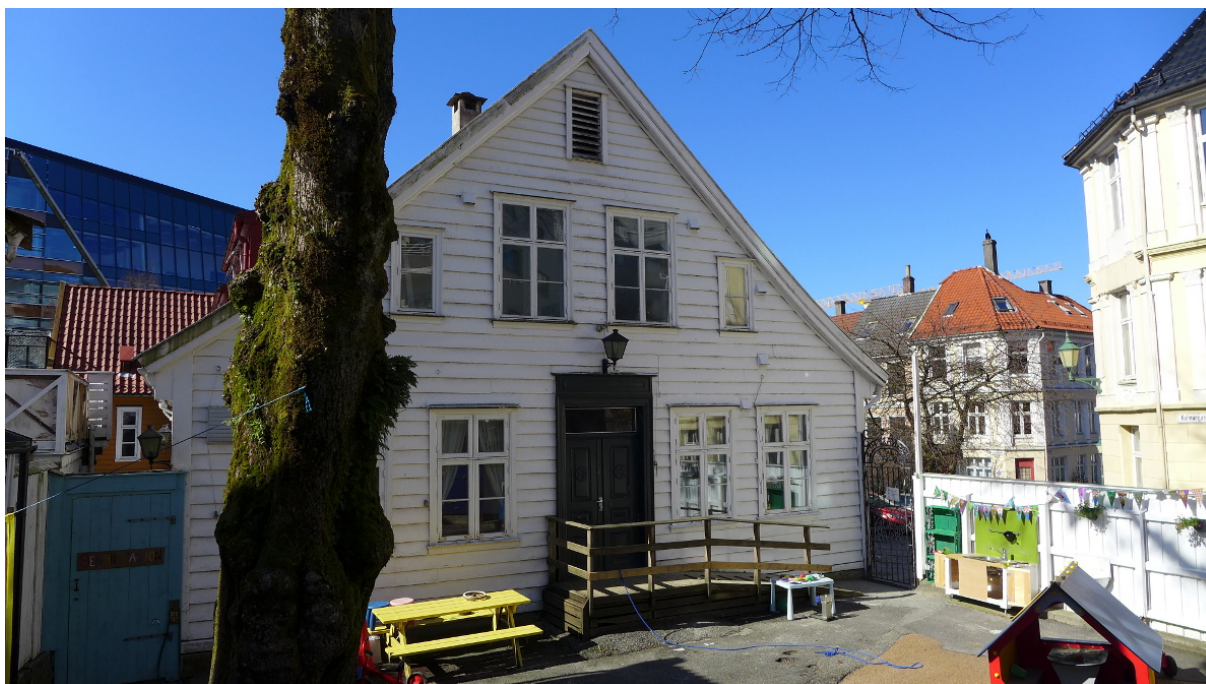
Figur 7. Nordøst-fasaden og uterommet til barnehagen. Fasaden har i form og fasademessig oppbygging klare referanser til gatefasader på de store 1700-talls gavlhusene for borgerskapet. Dette underbygger en tidlig datering for huset (foto: Byantikvaren 2015).
