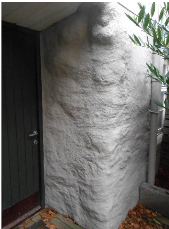
Figur 10. Inngang til kjelleren. Tykke, hvitkalkede natursteinsmurer (foto: Byantikvaren 2015).
