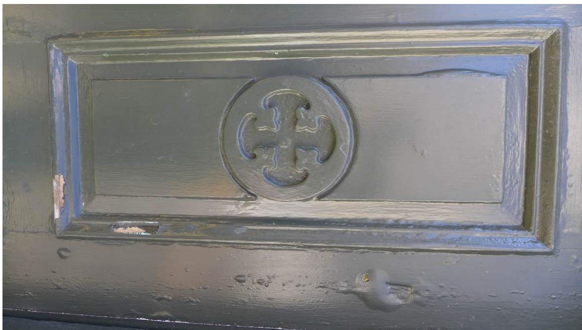
Figur 11. Detalj fra den eldre døren i nordøstgavlen. (foto: Byantikvaren 2015).
