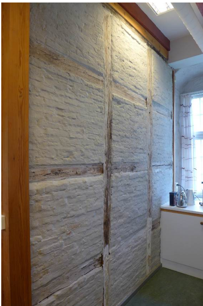
Figur 6. Eksempel på innvendig synlig bindingsverkvegg i sørfløyen (Foto: Bergen kommune, Byantikvaren 2015).
