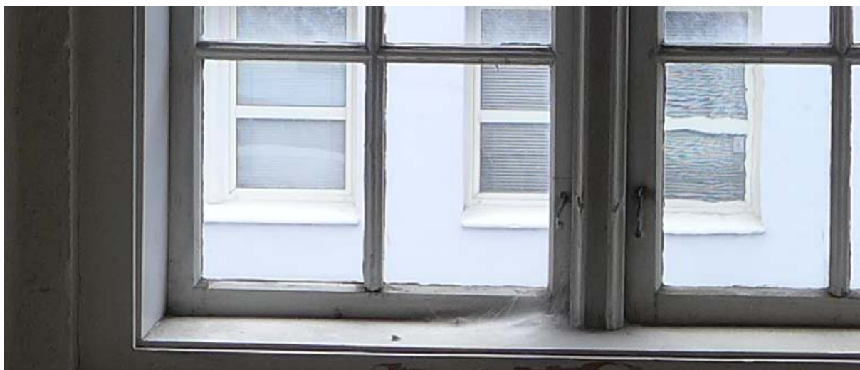
Figur 16. Eksempel på vindustype E i trapperommet ut mot Peter Motzfeldts gate. Dette er en av de yngre typene fra 1900-tallet (Foto: Bergen kommune, Byantikvaren 2015).
