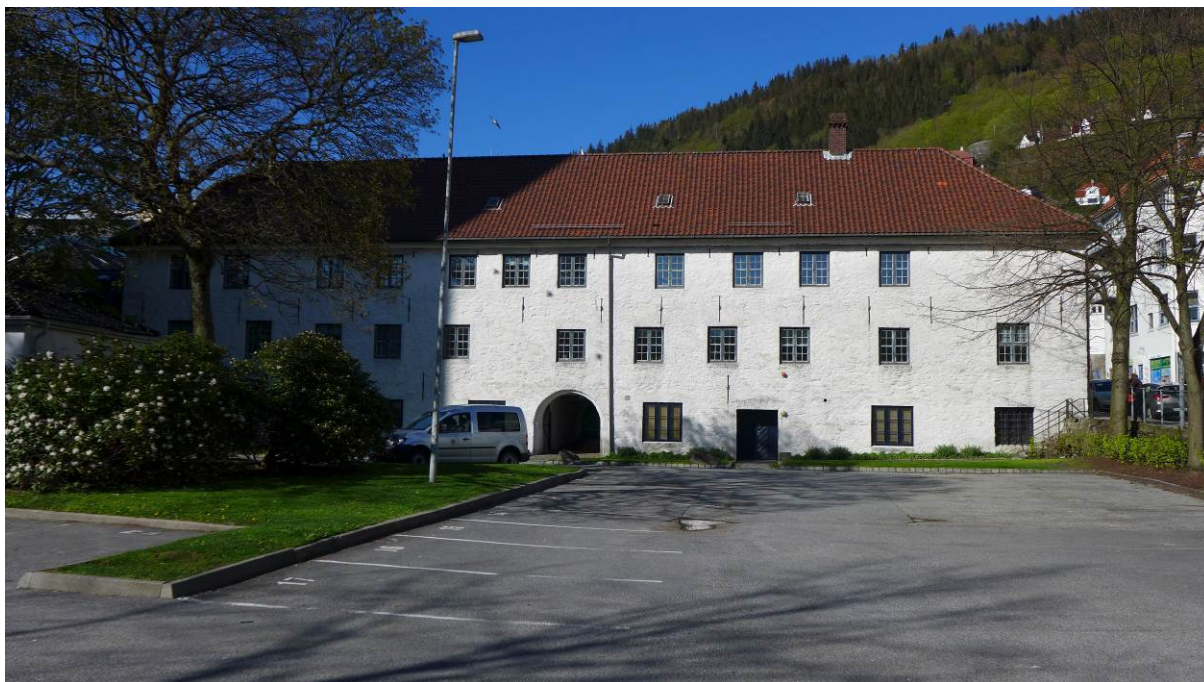
Figur 7. Fasaden ut mot Kaigaten. Tre etasjer med innredet loft i tillegg. Flere ulike typer vindu. Portrommet som deler første etasje i to sees midt på fasaden (Foto: Bergen kommune, Byantikvaren 2015).
