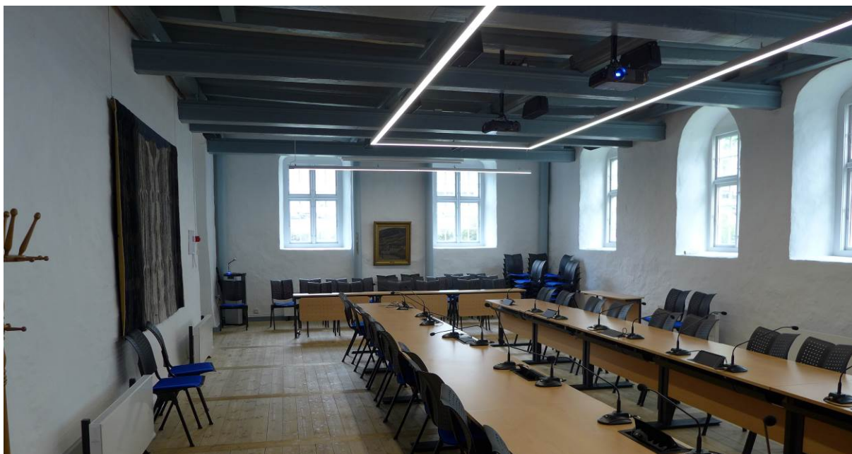
Figur 10. Teatersalen i første etasje av sørfløyen. Godt synlige takbjelker i himlingen (Foto: Bergen kommune, Byantikvaren 2015).
