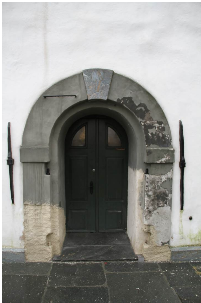
Figur 15. Rundbuet inngangsportale på sørgavlen av bygningen (Foto: Byantikvaren 2015).
