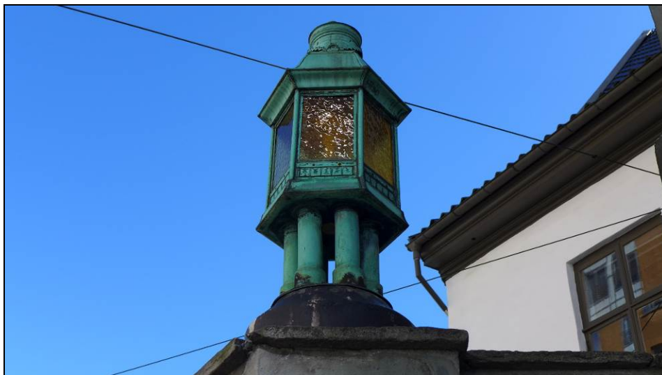
Figur 12. Utelykt i kobber på østsiden av bygningen (Foto: Byantikvaren 2015).
