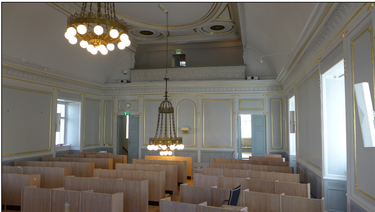
Figur 18. Bystyresalen under oppussing. Bildet er tatt mot sør med galleriet i bakgrunnen (Foto: Byantikvaren 2015).
