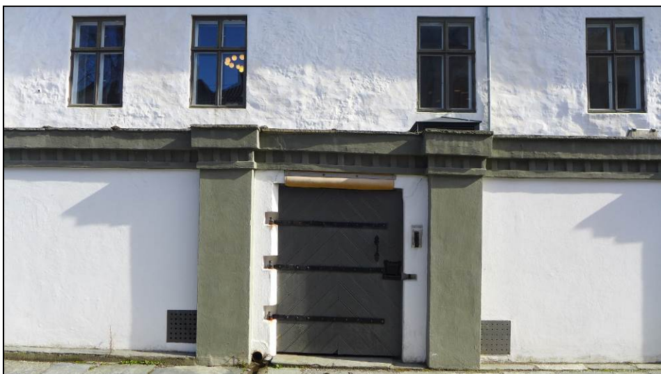
Figur 14. Inngangsdør på sørvestsiden av bygningen (Foto: Byantikvaren 2015).
