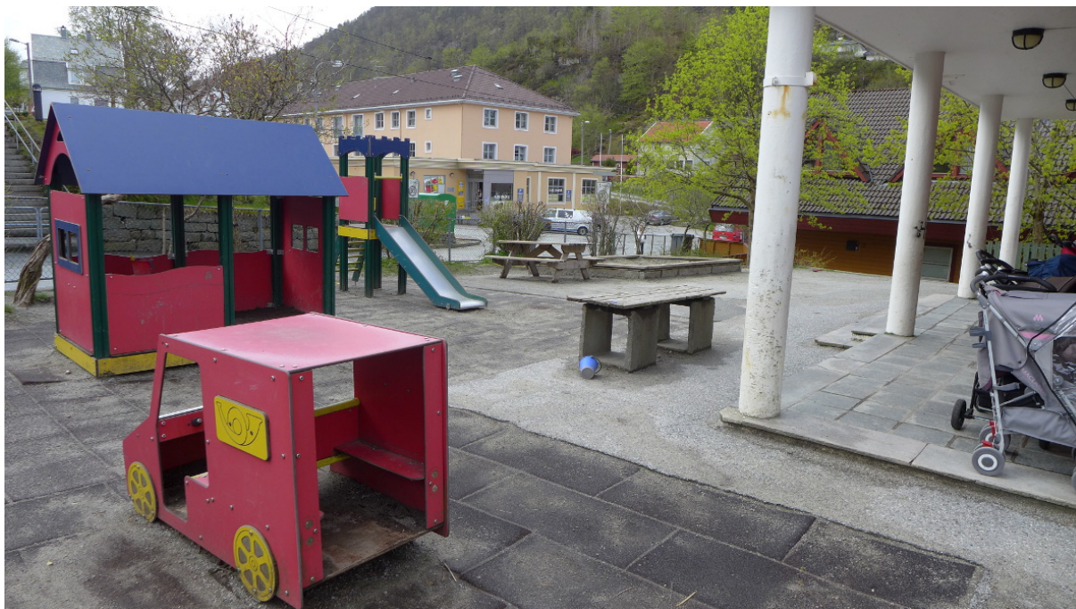
Figur 21. Lekeområde på sørsiden av bygningen (Foto: Byantikvaren 2015).
