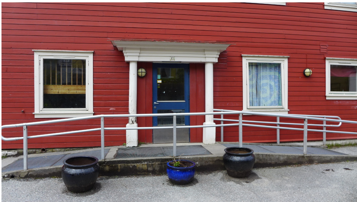
Figur 12. Dagens hovedinngang med søyler har opprinnelig plassering. Imidlertid er omramming endret i forbindelse med ombygging til daghjem i 1947. Dørbladet og den doble rullestolrampen er av nyere dato (Foto: Byantikvaren 2015).
