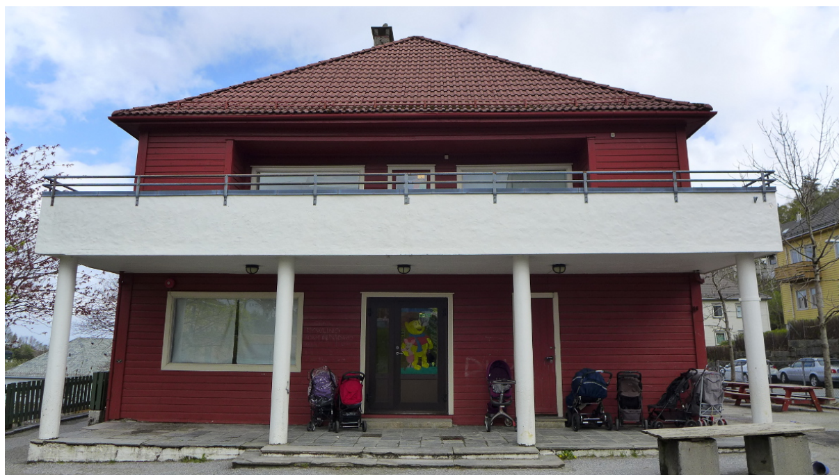
Figur 11. Balkong og søylegang i sørenden er ikke opprinnelig men ble oppført i 1947 i forbindelse med ombygging til internat og daghjem (Foto: Byantikvaren 2015).
