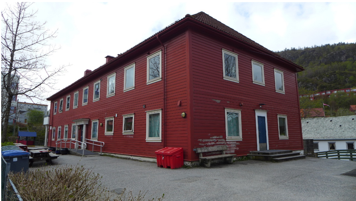
Figur 8. Øst- og nordlig fasade til Sverre Hjetlands vei 17. På gavlsiden har vinduer og døråpning sin opprinnelige plassering (Foto: Byantikvaren 2015).
