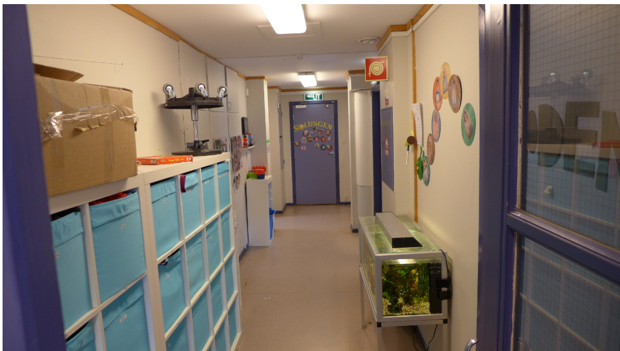
Figur 16. Mesteparten av veggflater og himlinger er dekket med plater (Foto: Byantikvaren 2015).
