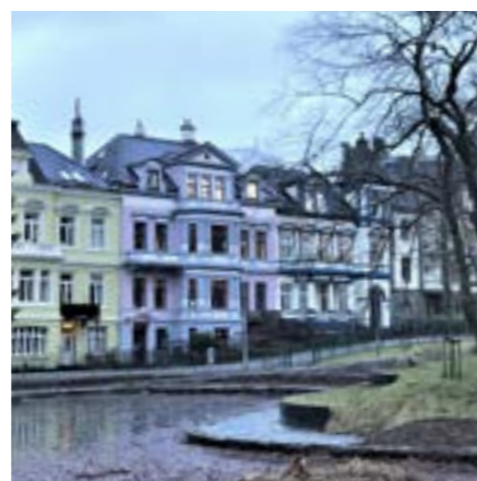
Bygårdene i Parkveien på Nygårdshøyden har høye arkitektoniske kvaliteter, bygget for byborgerskapet.
