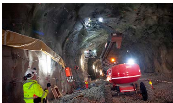
VOGNHALLEN: I den enorme vognhallen jobber de nå med tetting og innredning. Fasaden til vognhallen er forventet klar fra høsten 2021.
