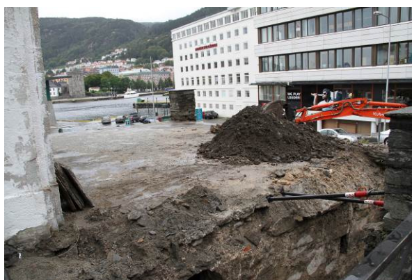
Fig. 15. Steinhellene lå i et sandlag over et 5 cm tykt, sammenhengende sementlag (foto: Byantikvaren 2013).
