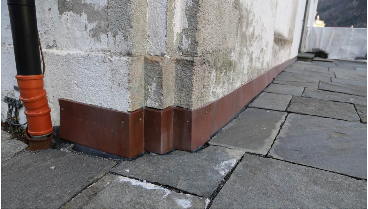
Fig. 16. Et kobberbeslag ble reifet inn i kirkeveggen for å motvirke lekkasjer til ruinrommene under (foto: Byantikvaren 2009).
