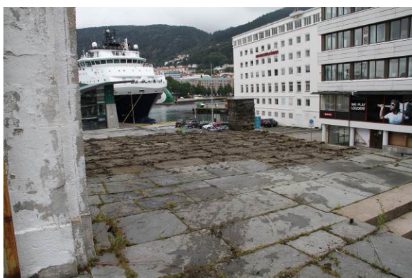
Fig. 14. Terrassedekket ble demontert (foto: Byantikvaren 2013).
