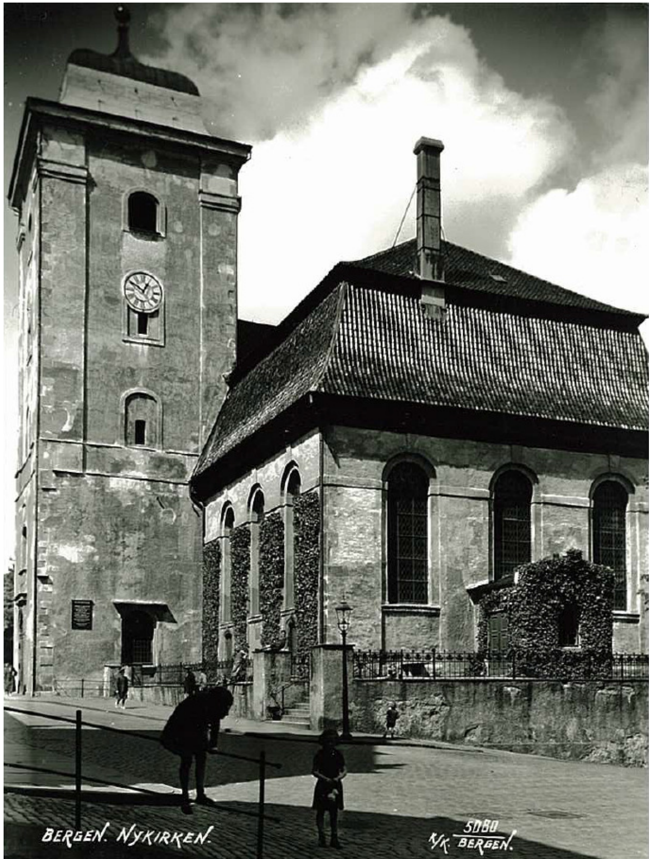
Fig. 1. Sørsiden av Nykirken med terrassen før eksplosjonsulykken i 1944. Nøyaktig tidspunkt er ukjent, men det dreier seg antagelig om mellomkrigstiden. Merk tilbygget på terrassen, et «våpenhus» i mur, og at murlivene i terrassen er pusset (Postkort, Knud Knudsen).
