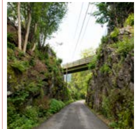
Vossabanen. Kurvatur, murer og skjæringer. Parti fra traseen mellom Hop og Fjøsanger.
