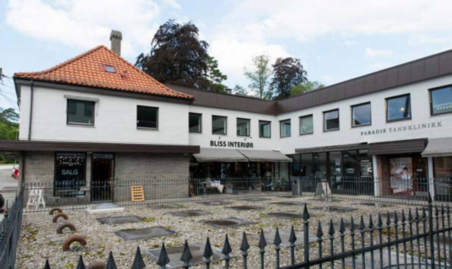
Paradis lokalsenter: Det som først var flere enkeltstående forretningsbygg, oppført for herr J. H. Bremer er blitt et knutepunkt som fremstår i dag som et helhetlig anlegg. Flere av våre fremste arkitekter har satt sin signatur på de ulike bygningsmessige tilføysene, arkitekt Torgeir Alvsaker, Halvorsen & Sørvig og Fr. Theodor Olsen er eksempler på dette.
