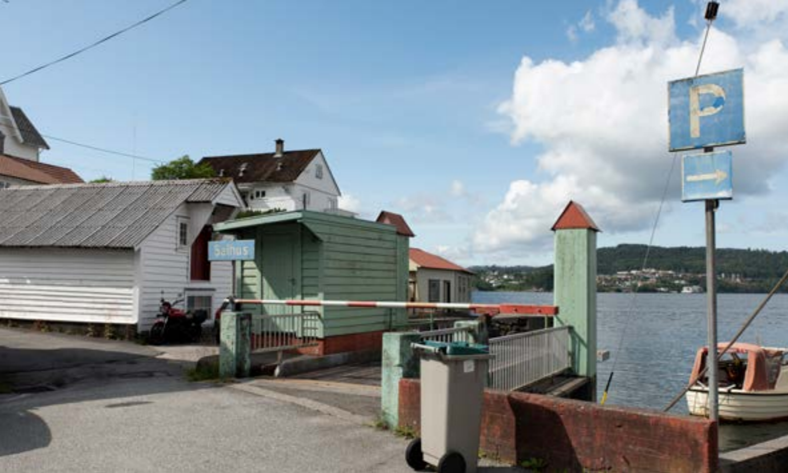
Salhus var et viktig transportpunkt for reisende til og fra Bergen mot nord. Ferjekaien er typisk for si tid, med to betongtårn, vinsj og lem med tredekke. (Foto: Christine Hvidsten)
