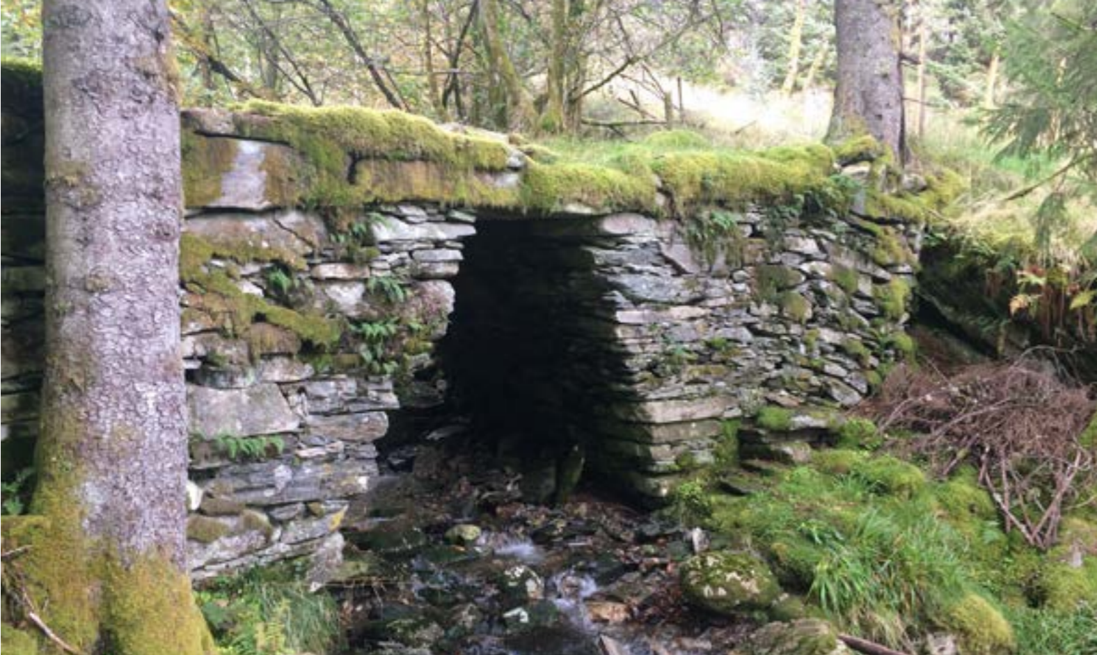
Tørrmurt hellebro på postveien ved Grytebekken mellom Grimen og Haugo, trolig fra slutten av 1700-tallet. Den erstattet en eldre bro, sto ferdig i 1821 og skal ha kostet 170 spesiedaler. Veilegemet består av flate heller lagt utkragende oppå hverandre. Denne konstruksjonsmåten ble i løpet av 1800-tallet mer eller mindre erstattet av steinhvelvkonstruksjoner der huggen stein ble kilt inntil hverandre for å danne en hvelving som kunne holde vekten av broen. Bevarte hellebroer er svært sjeldne.
