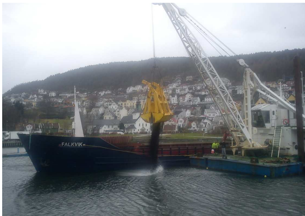
Figur 10 Plassering av Bioblok Gate PAC i felt 3, april 2011
