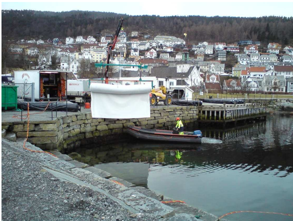
Figur 8 Utplassering av reaktive matter (RCM) i Kirkebukten mars 2011
