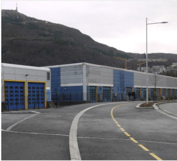
Møllendalsveien med pumpestasjonen til venstre
