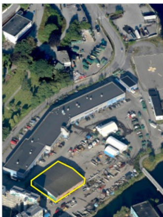
"Belsenbygget" har et areal på ca 1400 m 2
