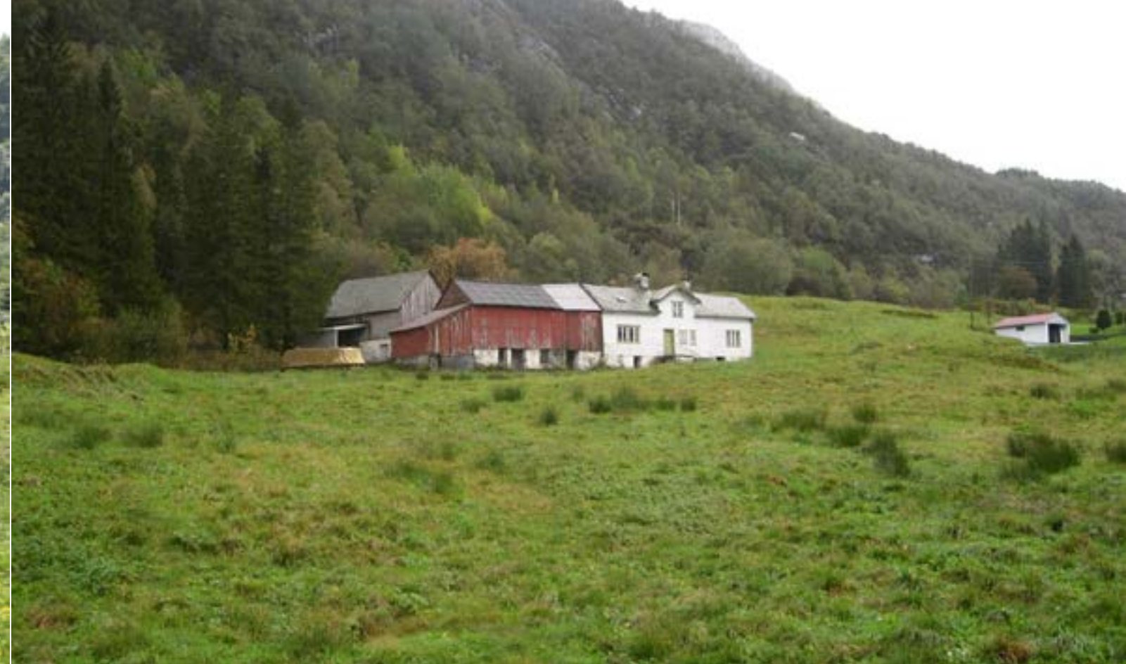
Sammenhengende gårdsanlegg, bruksnummer 3 på gården Espeland i Arna. Bruket oppstod ved deling av bnr.2 i 1863, og bygningene ble tatt i bruk i 1864. Garasjen i bildet står der det gamle gårdstunet lå.
