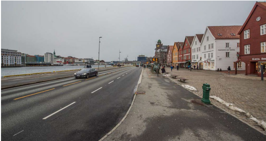
Dagens trafikksituasjon på Bryggen, med to kjørefelt, pluss lomme for taxi, varelevering og bussholdeplass.
