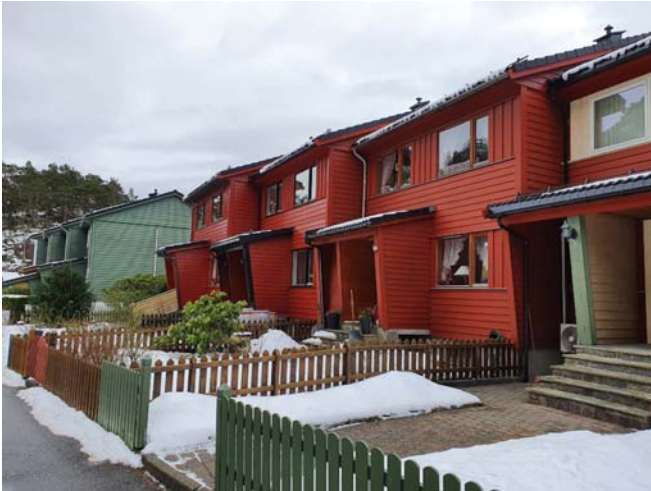
Figur 21: Inngangsfasadene til rekkehusene i Ravnaberget (Foto: Byantikvaren 2021).
