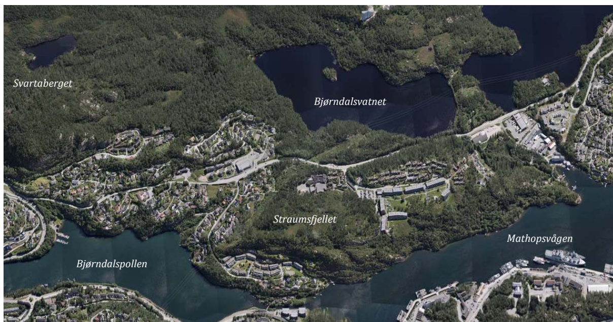
Figur 3: Skråfoto av undersøkelsesområdet mot øst. (Foto: Utsnitt fra skråfoto, Blom urbex, VISGI, Bergen kommune).
