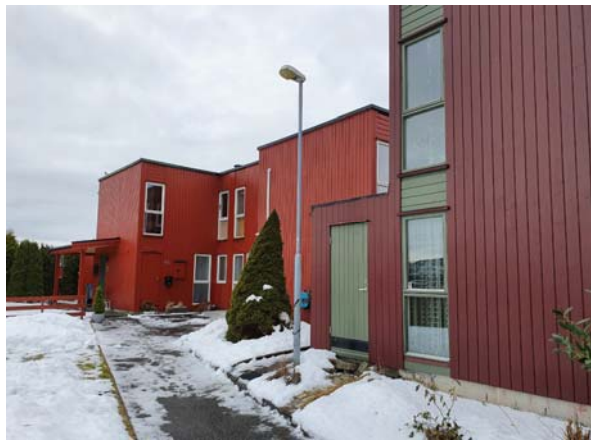
Figur 35: Tomannsboligene er godt bevart med opprinnelige flate tak og malt trepanel i ulike jordfarger (Foto: Byantikvaren 2021).
