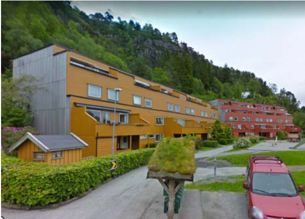
Figur 26: Husene var opprinnelig kledt med malt liggende panel i ulike jordfarger og endegavler i mur (Foto: Google Streetview).
