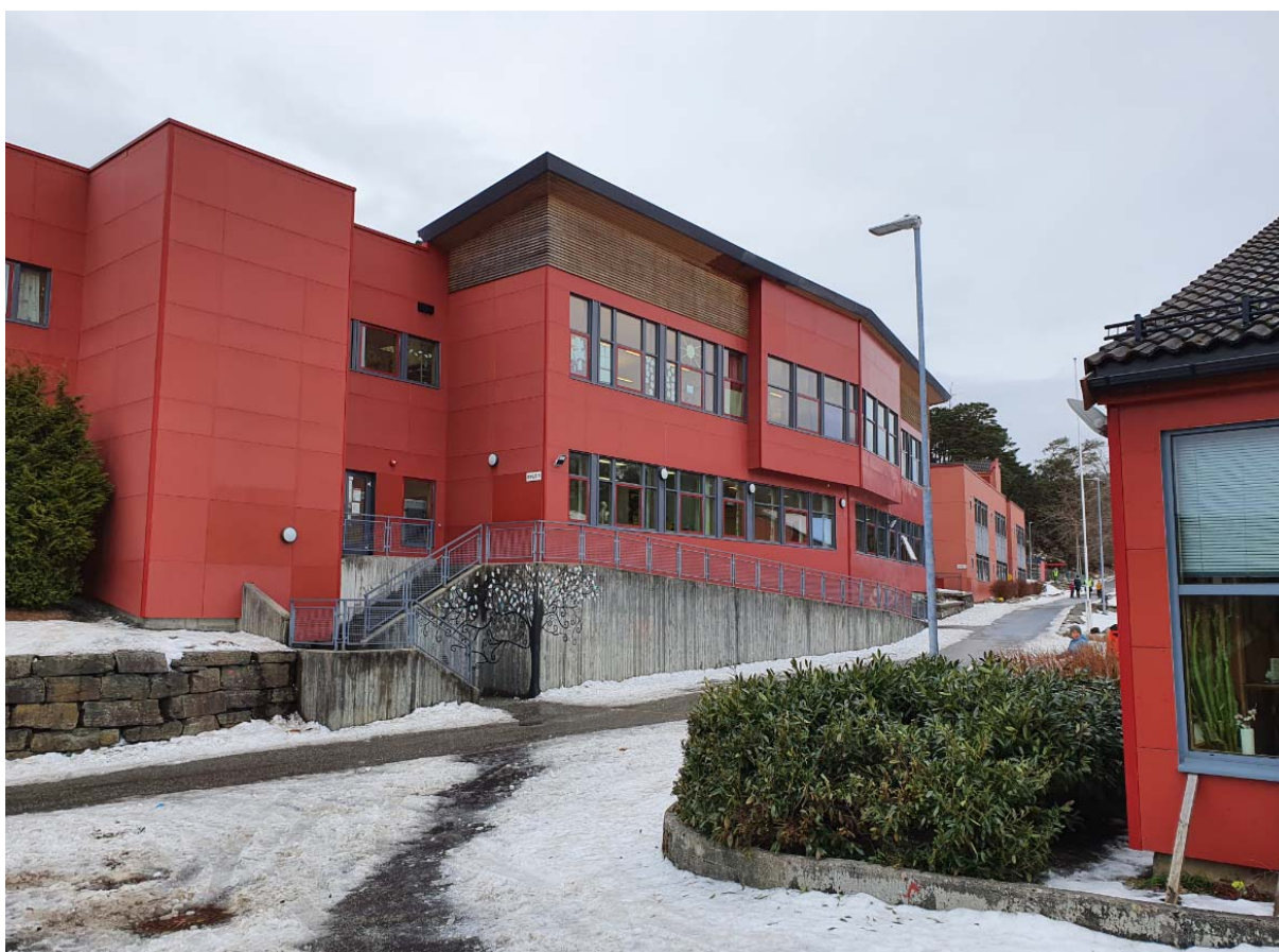
Figur 41: Bjørndalsskogen skole fotografert mot sør (Foto: Byantikvaren 2021).
