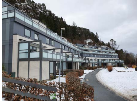
Figur 27: Hele borettslaget er i dag modernisert med samme type grå fasadeplater og frostet glass i altanene. Ombyggingen bryter med bebyggelsens opprinnelige arkitektoniske uttrykk (Foto: Byantikvaren 2021).
