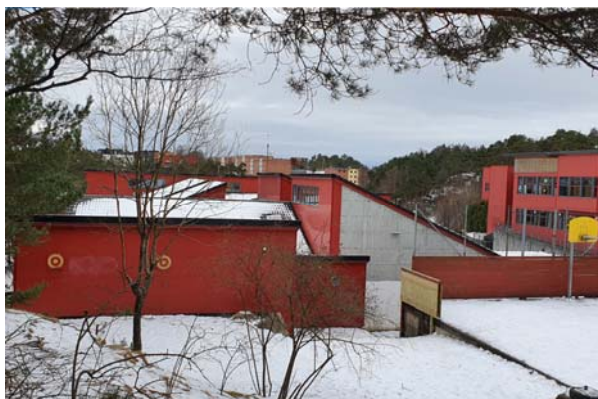
Figur 40: Bjørndalsskogen skole fotografert mot sør (Foto: Byantikvaren 2021).
