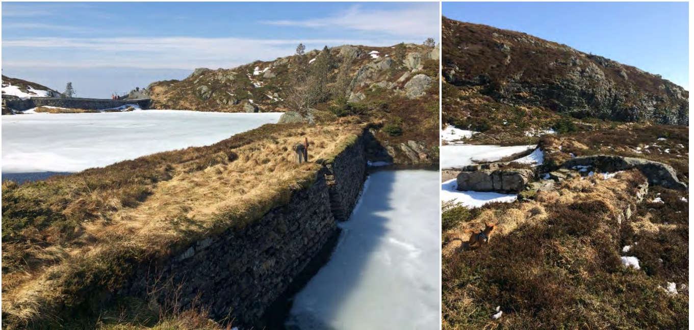
Figur 34 og 35: Lille Tindevann (E, Lillediket på Aad Gjelles kart fra 1824) har to dammer – her ser vi den nordre (hoved)demningen t.v. med tappemekanismen på oppstrøms side – damluken står åpen. Torvdammen er i relativt god forfatning. Den søndre dammen t.h. er i noe dårligere forfatning, men med åpen damluke i nordre dam når ikke vannivået opp til dammen under normale nedbørsforhold. Foto: Byantikvaren, våren 2020
