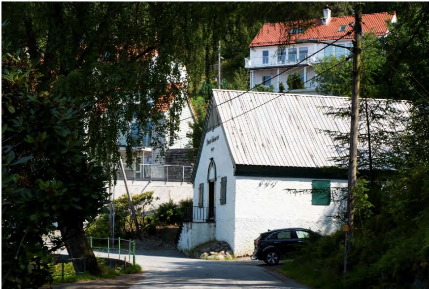
Figur 46: Reduksjonsbassenget til vannverket i Mulelven ligger like ved Fjellveien, og er et teknisk kulturminne fra 1914 med høy kulturminneverdi.
