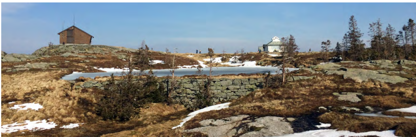
Figur 31: (G) «Pumpediket» rett sør for radiostasjonen på Rundemannen er i relativt god forfatning. Dammen kan ha vært vedlikeholdt med tanke på bruken som vannreservoar til radiostasjonen og de militære anleggene på Rundemannen. Foto: Byantikvaren, våren 2020.
