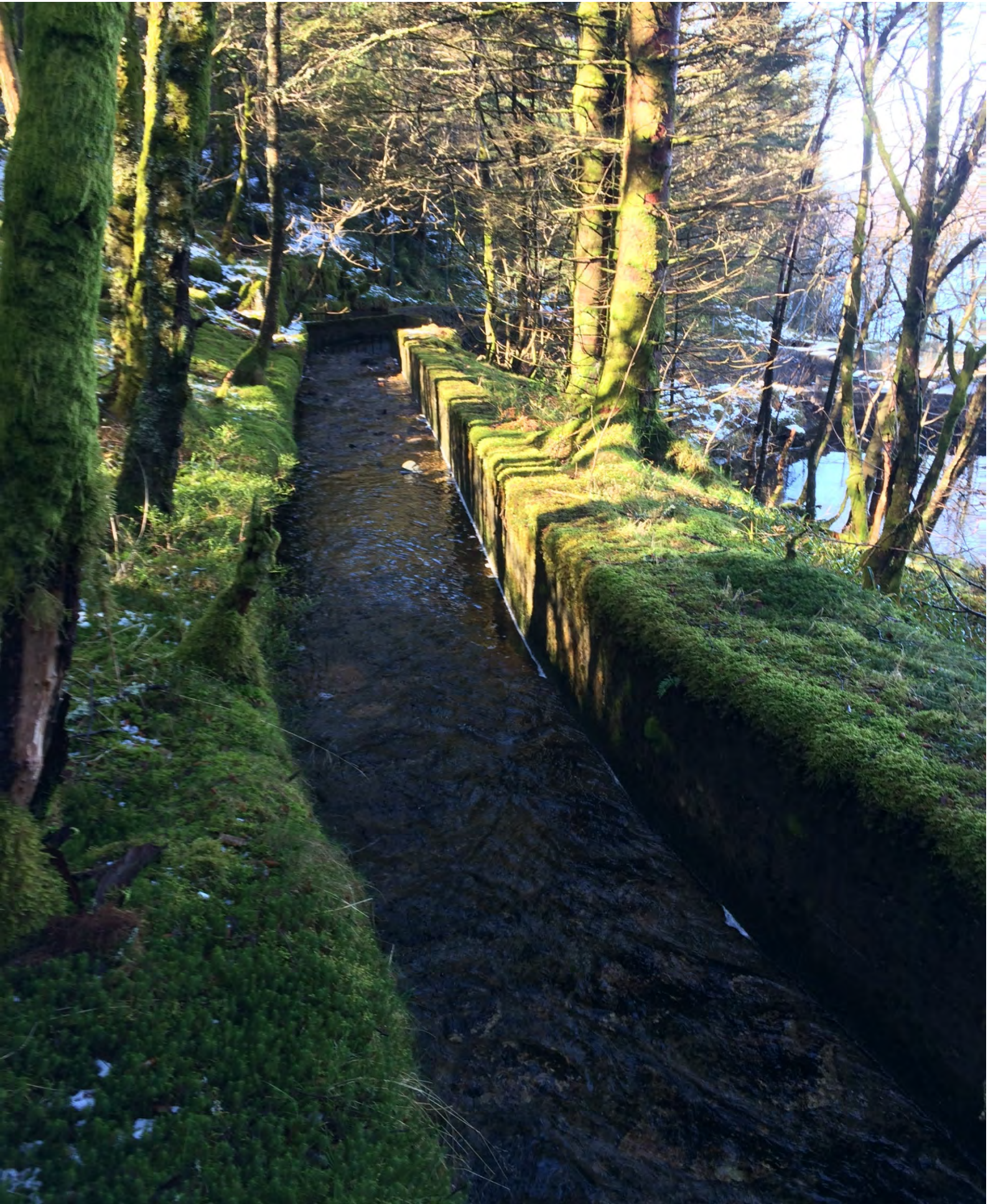
Figur 1: «Bypass»-kanal for flomvann ved inntaksdammen i Skredderdalen. Vannverket i Mulelvvassdraget og de gamle mølledammene er sammen med krigsminnene på Blåmanen viktige tekniske kulturminner innenfor kartleggingsområdet. Foto: Byantikvaren
