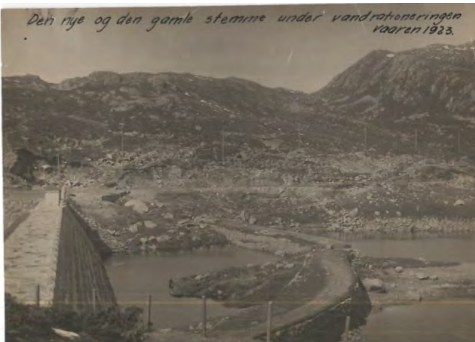
Figur 50: På dette bildet fra 1923 er "rock fill"-dammen ferdigstilt, mens løsmassedammen mot nord fortsatt er under arbeid. Vi ser tydelig høydeforskjellen (6,4 meter) mellom den nye og den gamle torvfylte dammen innenfor. (C på Aad Gjelles kart fra 1824)
