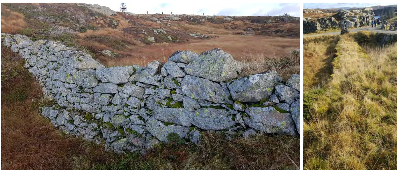
Figur 32-33: (H) «Rundemansdiket» (t.v. over) ligger et stykke lenger sør for radiostasjonen på Rundemannen. Nedstrøms vange er i relativt god forfatning. Nordre Tindebrekksdiket (I) ble nok i stor grad fjernet da Rundemansveien ble bygget, bildet t.v. over viser en damkonstruksjon som fremstår som rester av diket. Foto: Vann- og avløpsetaten.
