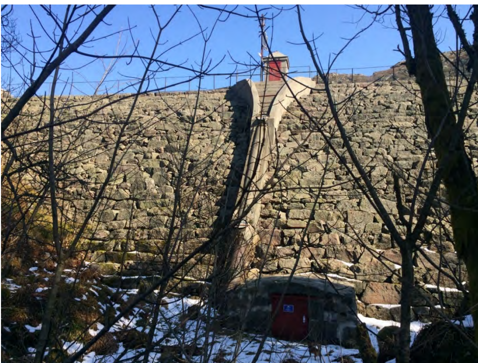
Figur 51: Den spesielle overløps-konstruksjonen på Storediket i betong og støpejern bidrar sammen med det støpte damhuset, der den tidligere fjernstyrte lukkemekanismen er plassert, til Storedikets høye verdi som teknisk kulturminne.
