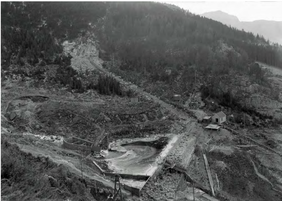
Figur 53: Oversiktsbilde over anleggsstedet i Skredderdalen tatt en gang i byggeperioden fra 1922-1924. Foto fra Vann- og avløpsetaten arkiv
