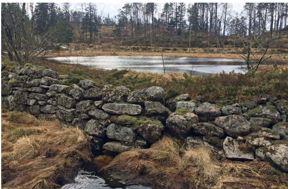
Figur 43: Tjønnen (P) ligger like ved lysløypen langs Storediket, men dammen er delvis ødelagt og tappeløpet slipper ut det aller meste av vannet som samles opp fra det lille nedbørsfeltet.
