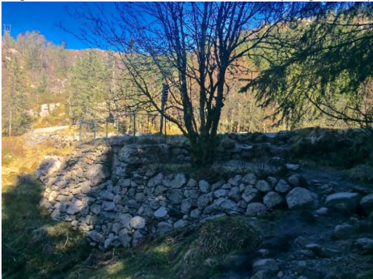
Figur 28 og 29: (A) Nedrediket (to bilder nedenfor) er sannsynligvis den eldste av dammene i Mulelvvassdraget og er delvis i dårlig forfatning, overløpet med kanalen med vannivåmåleren og ikke minst den støpte broplaten (bildet t.v.) er av nyere dato enn dammen for øvrig. Bruken av veien over dammen er kritisk med tanke på dagens akseltrykk. Foto: Byantikvaren, 2020
